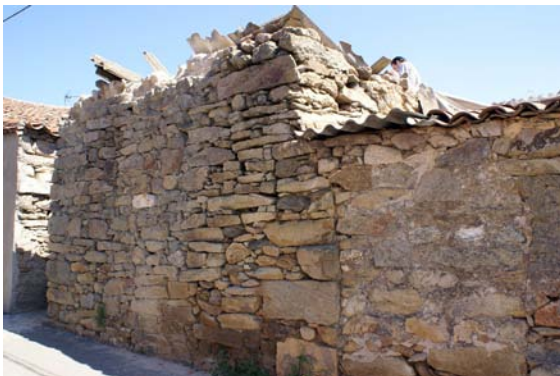
Vista exterior del horno
