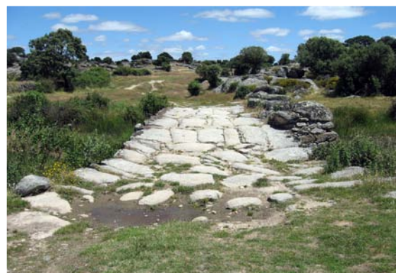
Vista de la calzada
