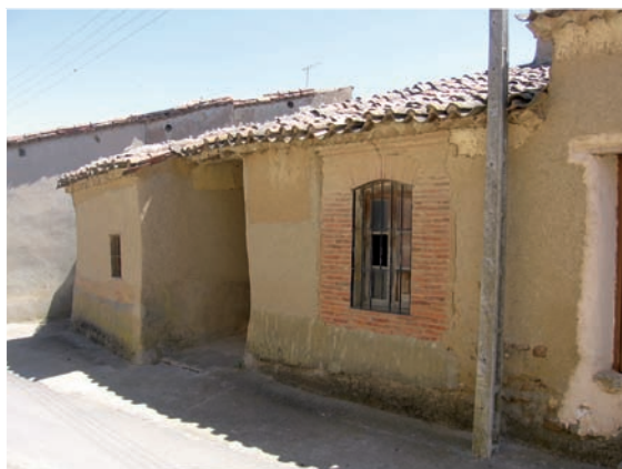
Recercado de vanos con finas labores de ladrillo
