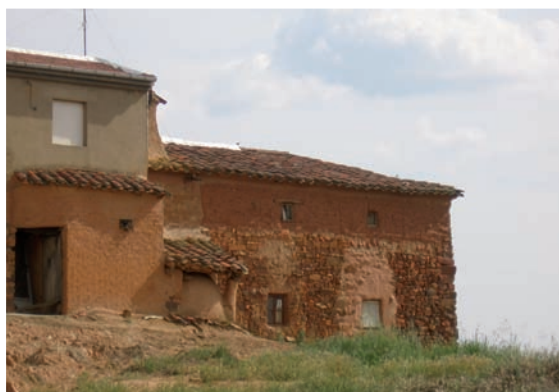
Vista de una de las edificaciones
