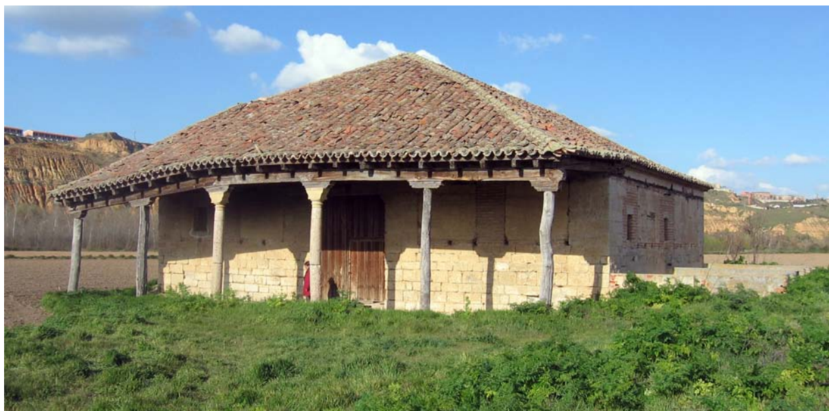
Vista de la fachada principal
