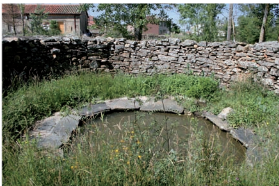
Lavadero de forma circular
