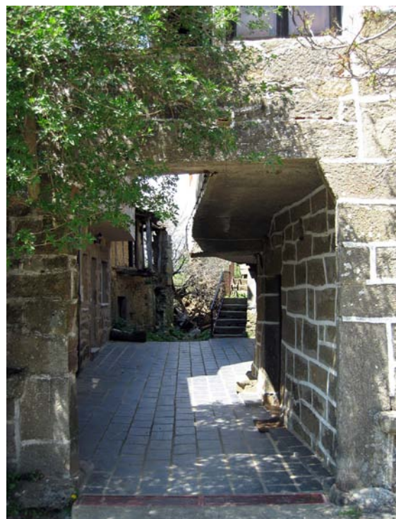
Vista del patio
