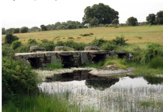
Imagen del puente y los contrafuertes
