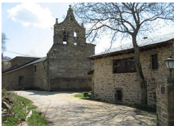
Vista de la iglesia y espadaña
