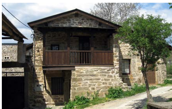
Vista de una de las viviendas rehabilitadas
