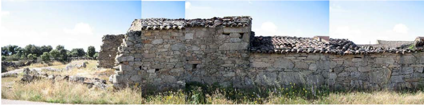
Alzado del conjunto a la carretera
