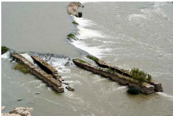
Detalle de los dos canales de piedra de la pesquera
