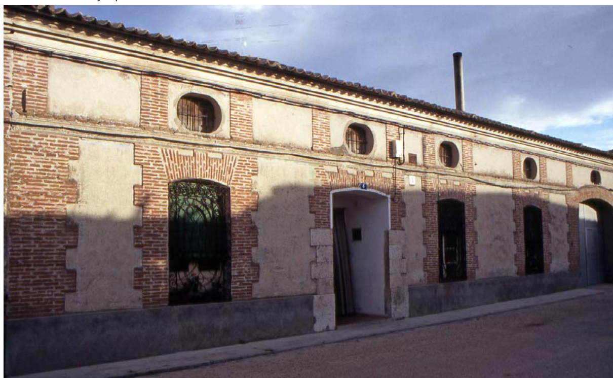
Vivienda de ladrillo y tapial en Llano de Olmedo
