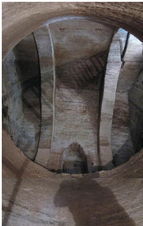
Vista del interior desde el fondo del pozo
