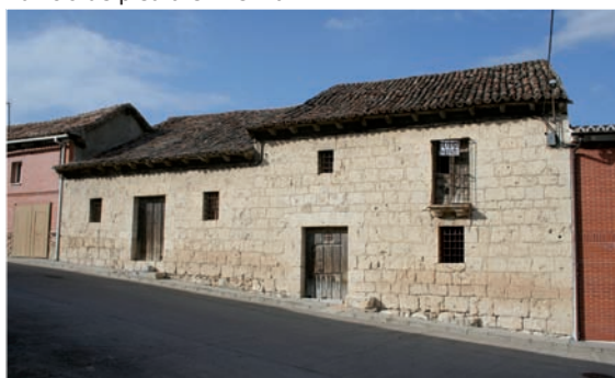
Edificio de piedra en Velliza
