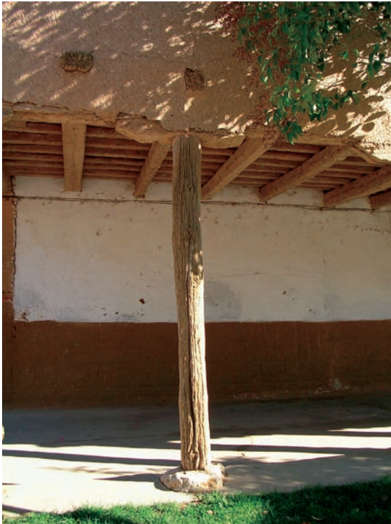
Detalle de pilar de madera de los soportales
