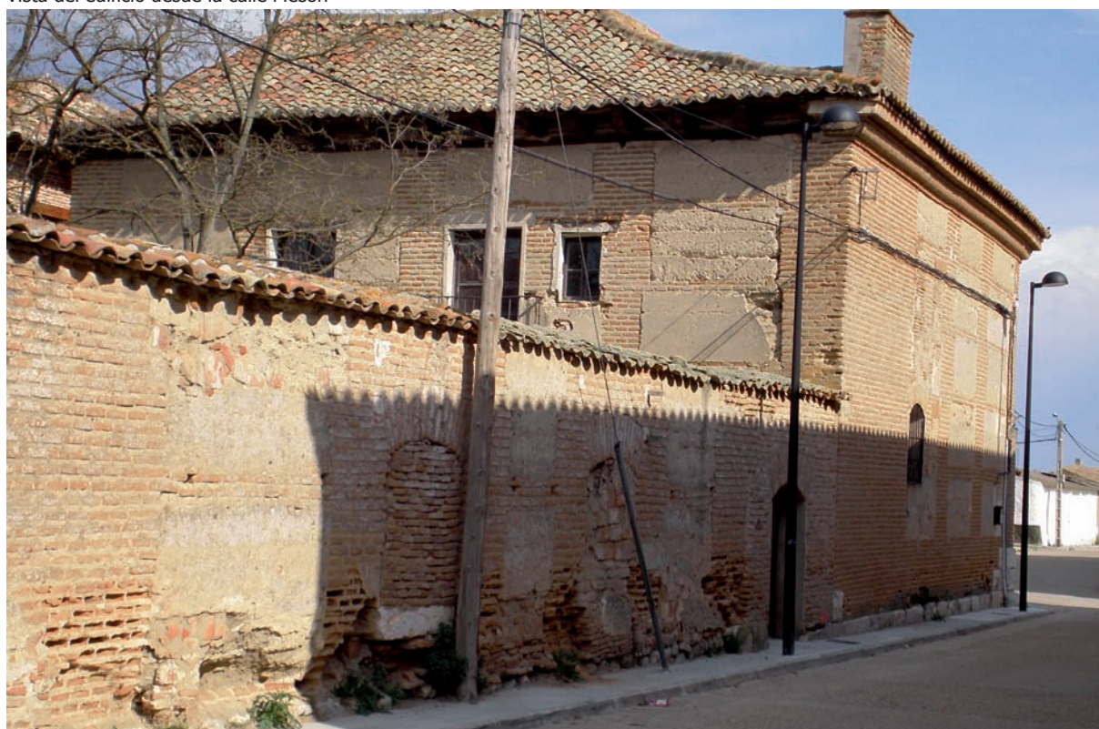
Vista del edificio desde la calle Mesón
