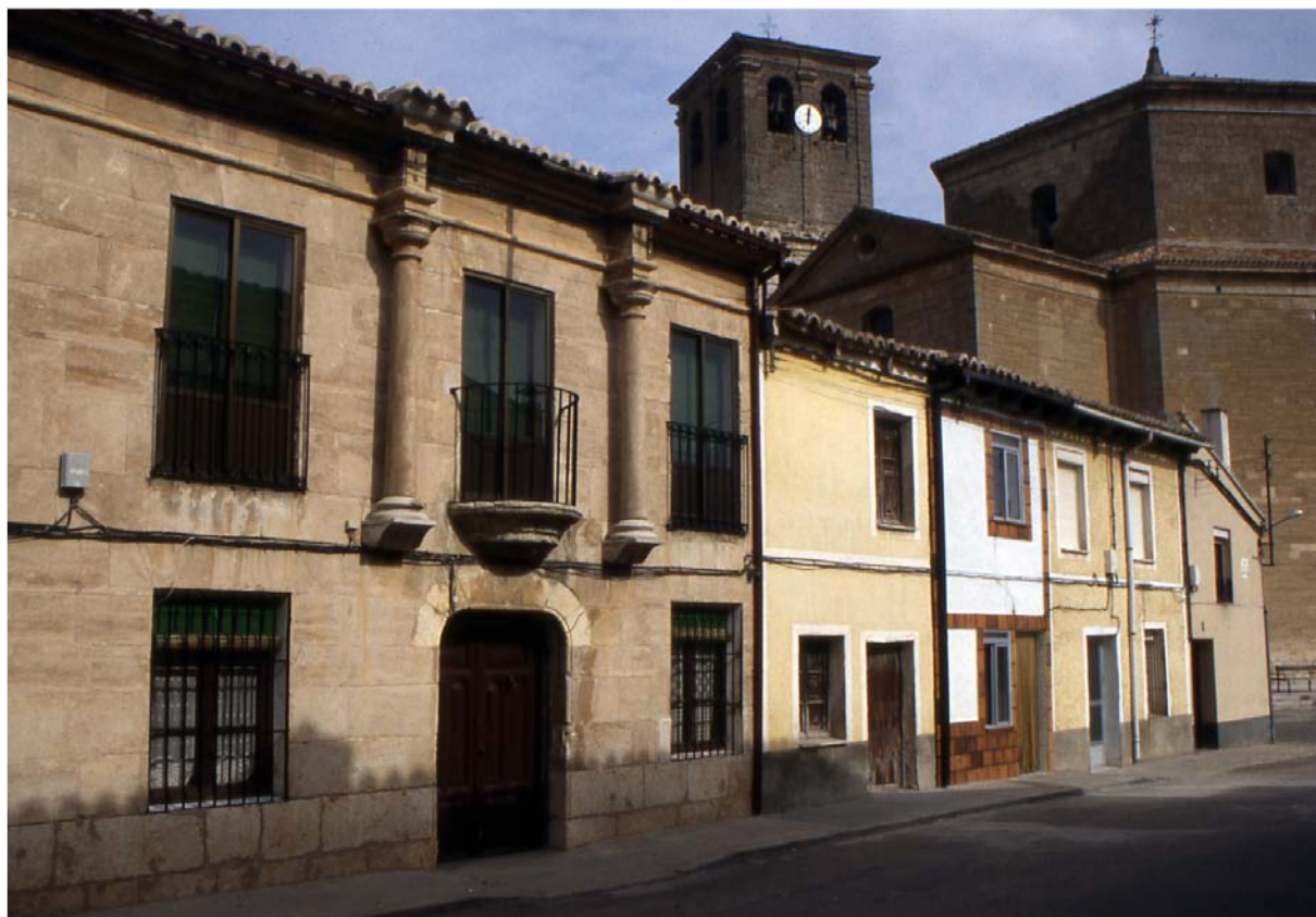
Palacio de sillería del siglo XIX en Valoria La Buena, actualmente muy reformada
