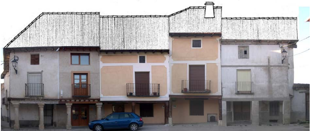
Fachada norte de la Plaza Mayor
