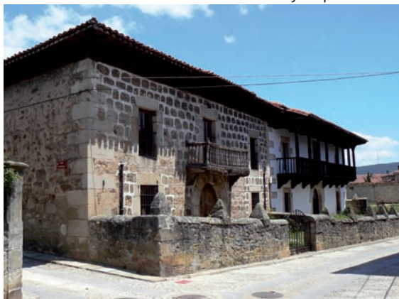
Vivienda en Vinuesa con sillería en huecos y esquinas
