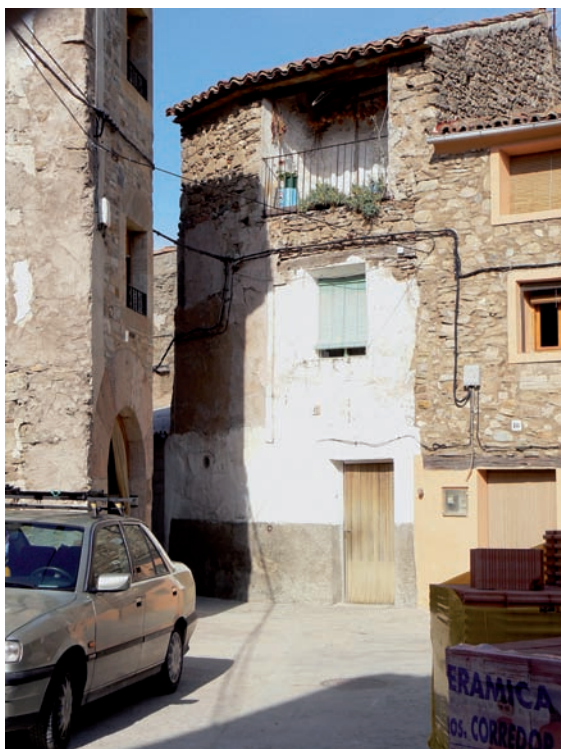
Edificio de la calle Portillo, 12
