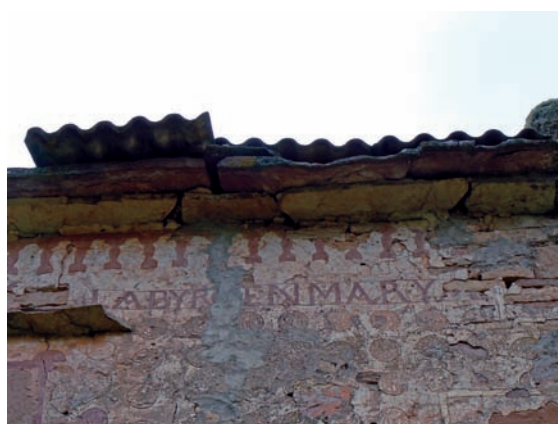
Detalle de la cubierta de lajas de pizarra
