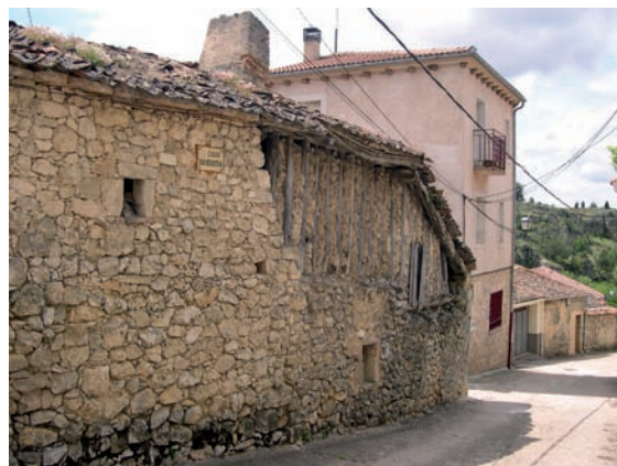
Vivienda en esquina de la calle Real con la calle Lagar. En la chimenea se aprecia el ladrillo de tejar con el que está construida
