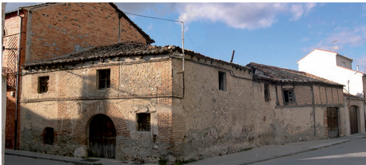
Calle Fragua, 9. Ladrillo en recercados, esquinas y dinteles, mampostería entre machones
