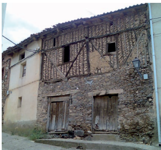
Vivienda con el típico muro mixto de mampostería y entramado de madera relleno de adobes en espiga
