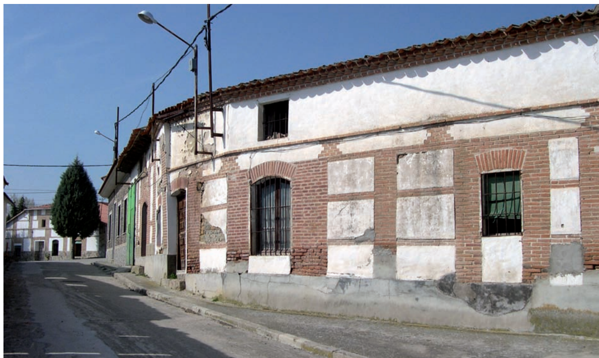
Edificio con machones y verdugadas de ladrillo en Fuente de Santa Cruz
