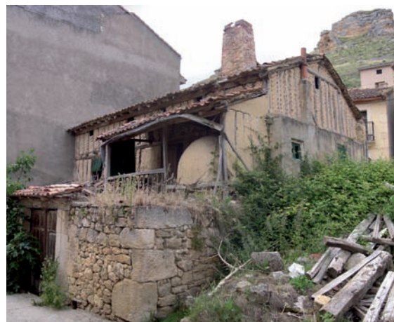
Vivienda con horno exterior, corredor y chimenea, en la calle Eras Abajo
