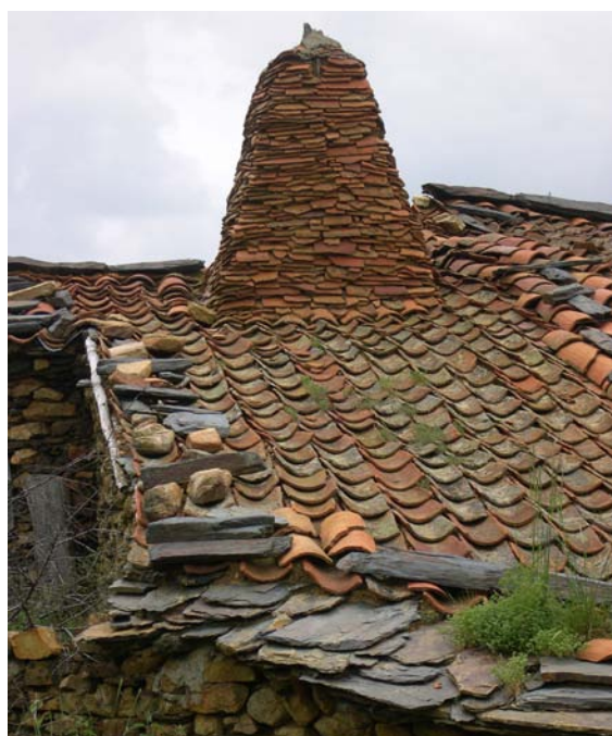
Martín Muñoz de Ayllón. Vivienda con cubierta de teja canal sobre antigua cubierta de pizarra y con chimenea troncopiramidal. Foto inferior: Zaguán de la vivienda.
