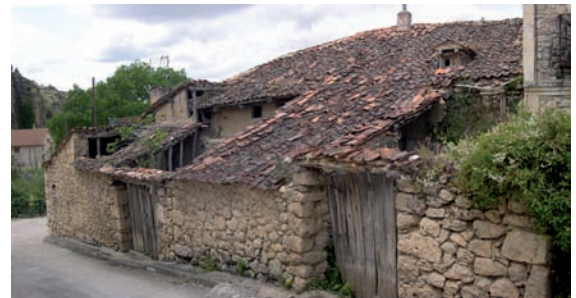
Ejemplo de portalón de corral en la calle Arroyo. El relleno del entramado es de adobe
