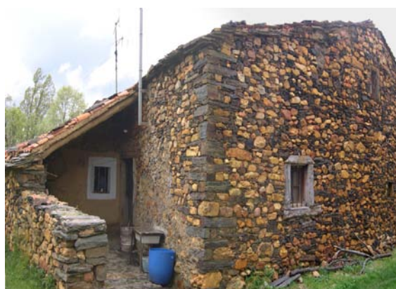
Martín Muñoz de Ayllón. Vivienda con cubierta de teja canal sobre antigua cubierta de pizarra y con chimenea troncopiramidal. Foto inferior: Zaguán de la vivienda.
