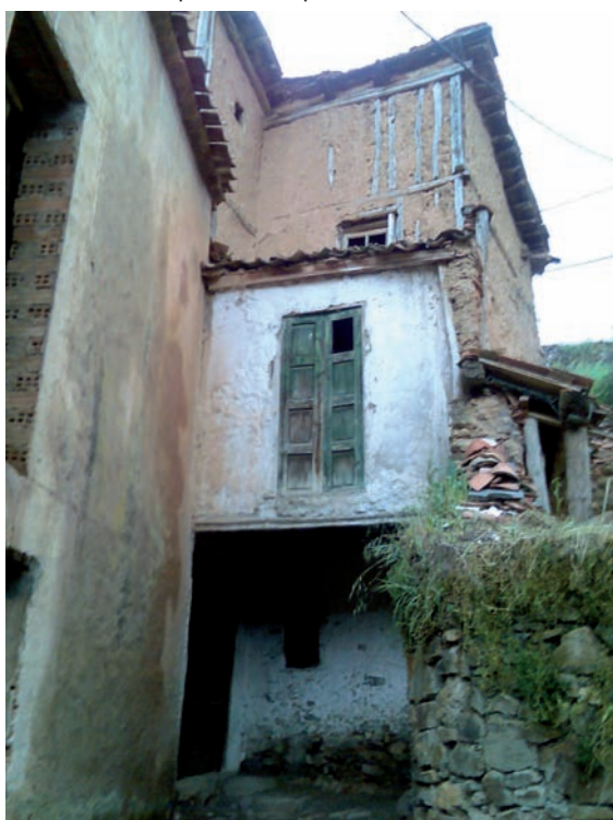
Vivienda de tres plantas con pasadizo
