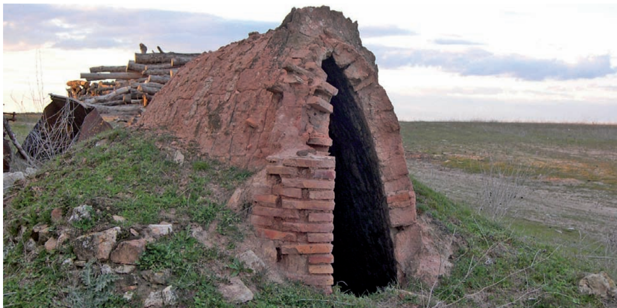
Lastras de Cuéllar. Peguera de adobe y ladrillo
