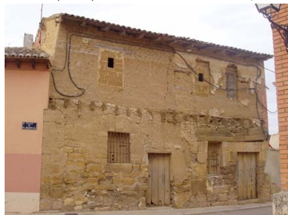
Edificio de piedra y barro en la calle Mauro Polanco, 13
