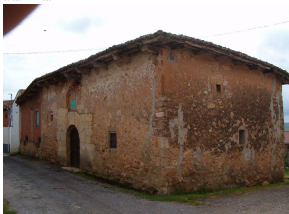
Edificio de tierra, con planta baja de mampuesto y sillar y alta mixta
