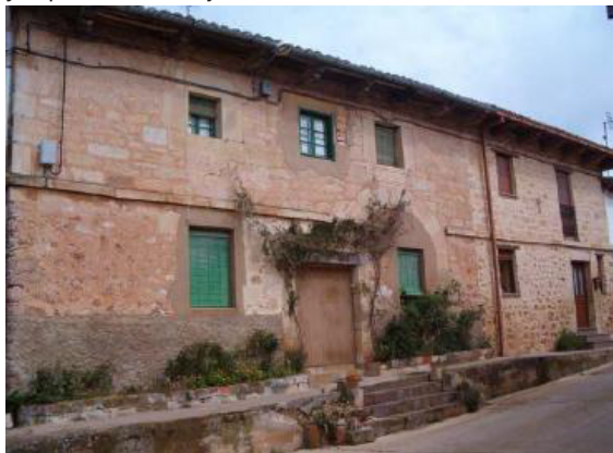
Edificio en la calle Escuelas, con planta baja de mampuesto y superior de sillarejo
