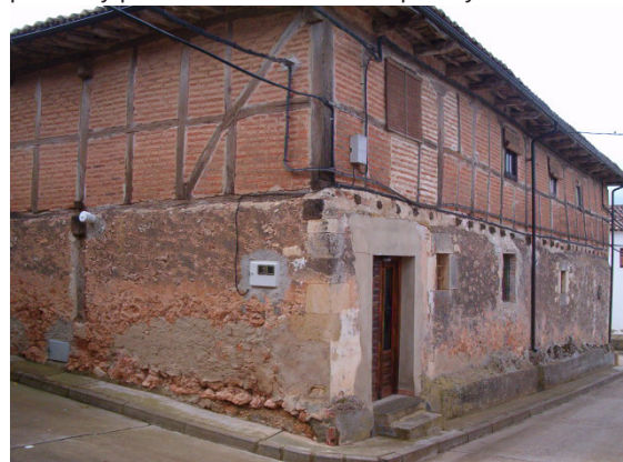
Edificio en la calle Hospital, 11, con planta baja de mampostería y planta alta con ladrillo de "poste y carrera"
