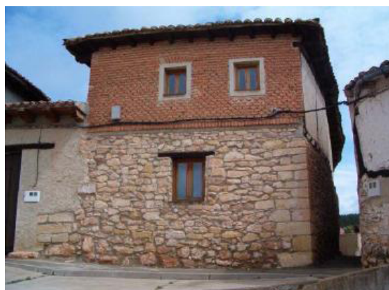
Edificio de sillares y mampostería en planta baja, y con planta superior de ladrillo
