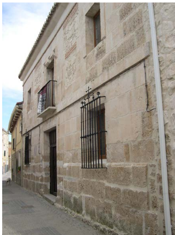
Edificio en la calle Trinquete
