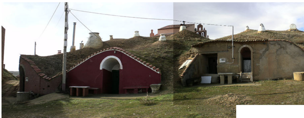
Conjunto de bodegas
