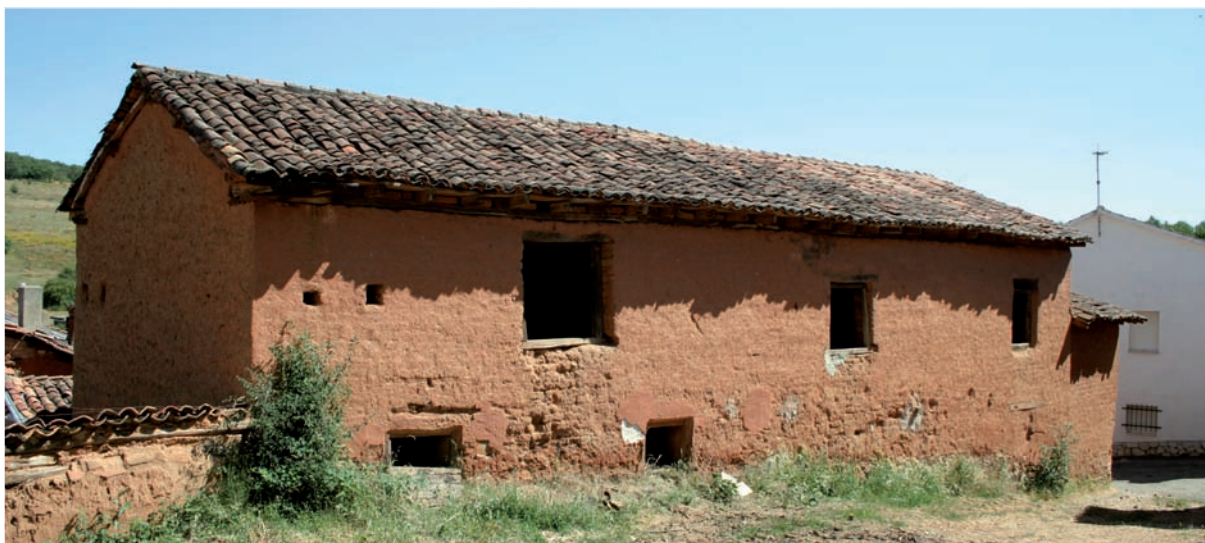
Edificio secundario de fábrica de adobe y tapial
