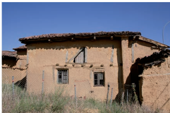
Ejemplo de arquitectura de entramados de madera en Villamartín de Don Sancho
