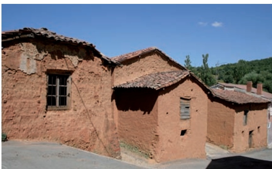
Conjunto de edificios secundarios
