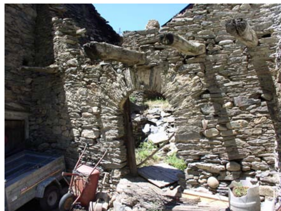
Arco adovelado corredor abierto
