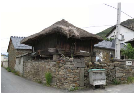
Hórreo de cubierta de teito en Villager de Laciana
