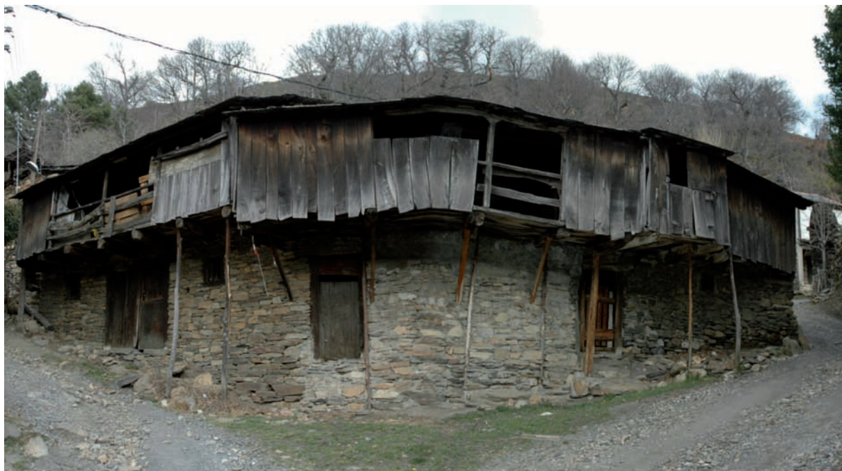
Edificio con corredor exterior de madera en Montes de Valdueza
