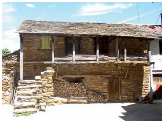
Casa corredor con escalera de dos tramos
