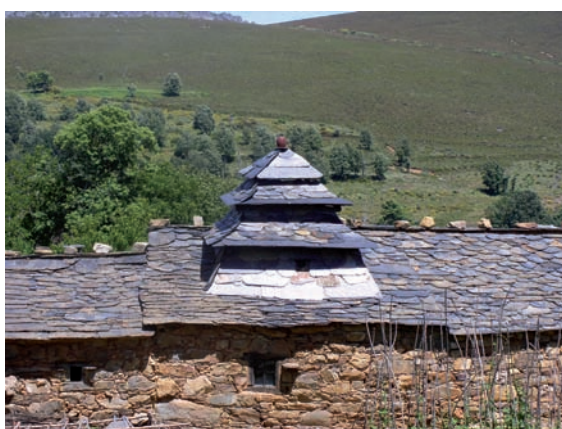
Detalle de la chimenea en una de las edificaciones
