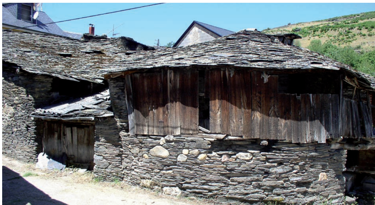
Casa corredor de Santa Eulalia de Cabrera
