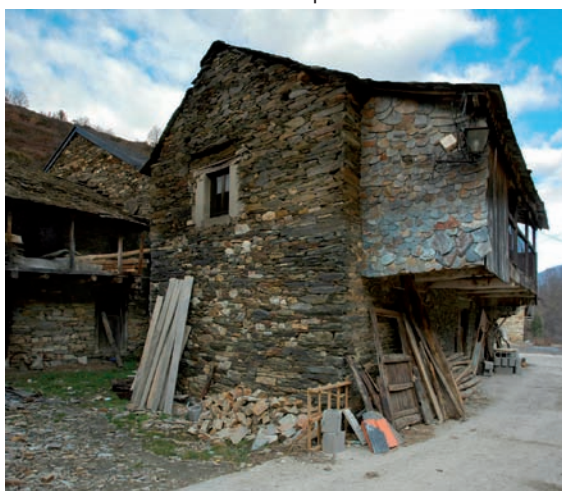
Edificio con corredor exterior de pizarra
