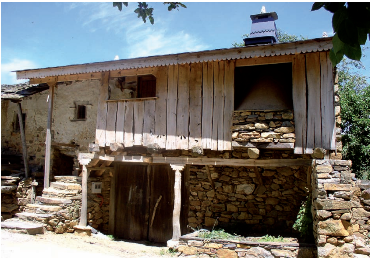
Casa corredor en proceso de restauración
