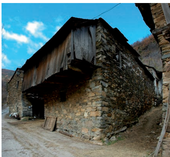
Edificio con corredor exterior de madera
