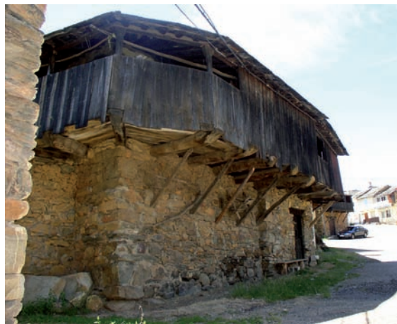
Casa corredor en esquina sustentado por tornapuntas
