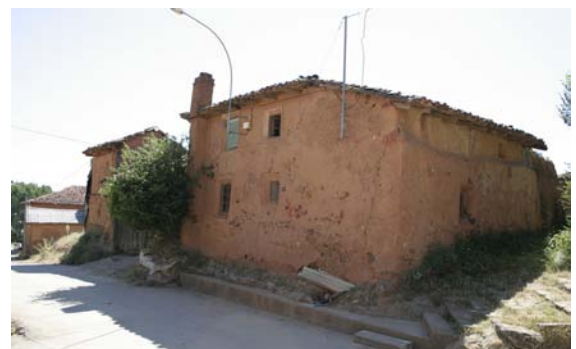
Edificio residencial muy característico de la tipología de la arquitectura de la comarca de almanza
