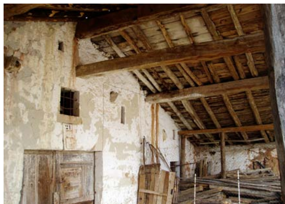
Interior del Porche, el esquema estructural es prolongación de la estructura interior el edificio
