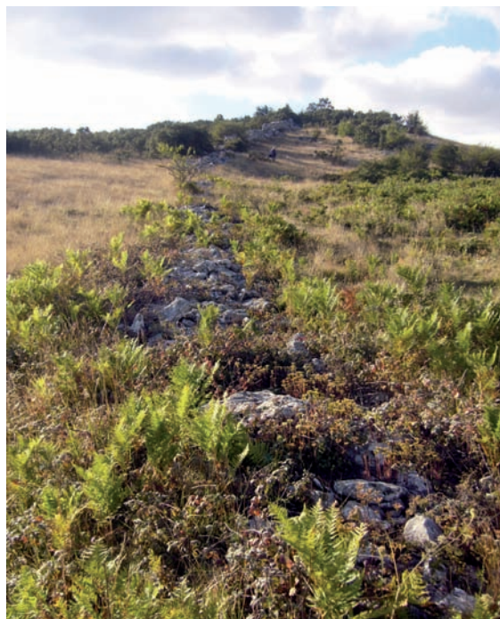
Pared derrumbada de la lobera de Huidobro
