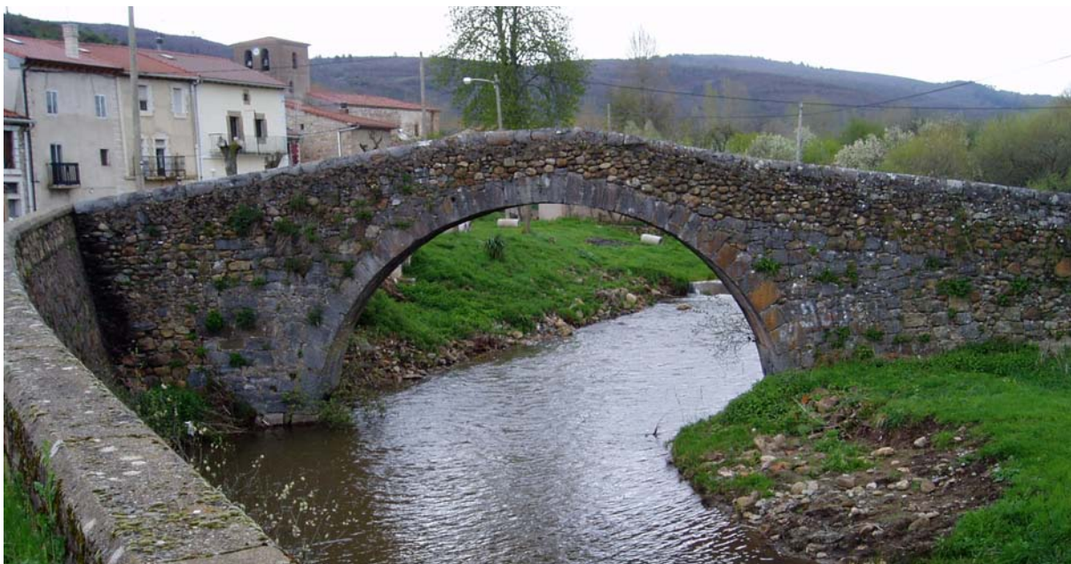
Vallejimeno, puente sobre el río que atraviesa la localidad. Medio arco de piedra bien labrada con pretil de mampostería
