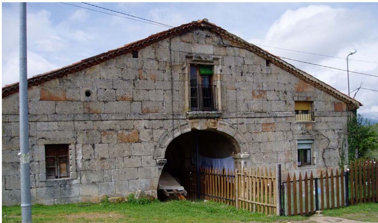
Casa carretera, edificio de planta rectangular con fachada en piñón totalmente simétrica, ejecutado de buena fábrica de sillería
