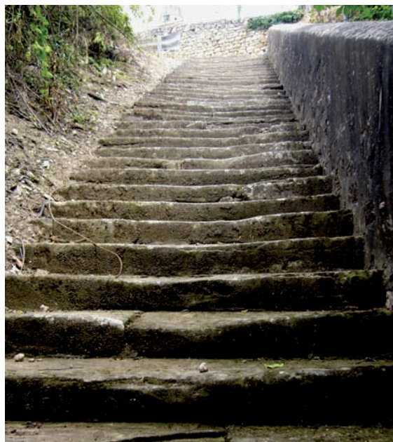
Escaleras de acceso a la Fuente Vieja de Treviño
