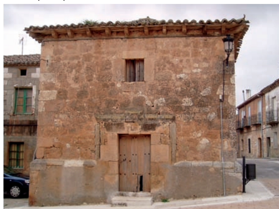
Alzado principal del edificio
