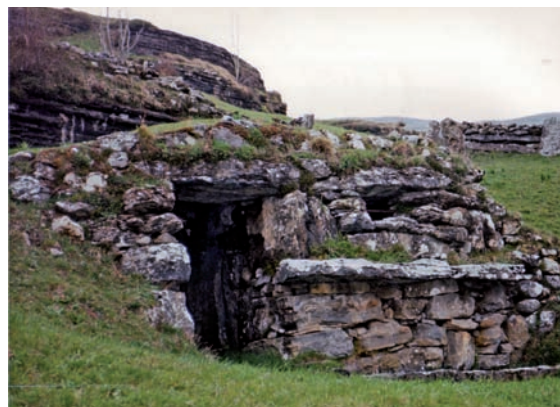
Fachada de bodega pasiega en Trueba
