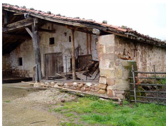
Alero y muro de piedra que cierra el lateral del edificio. El prado anexo se configura como espacio auxiliar para los animales
