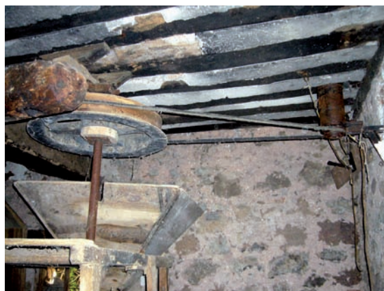
Rueda motriz y dinamo acoplada en el interior del molino
