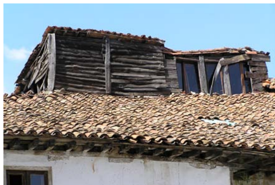
Detalle de la cubierta del edificio
