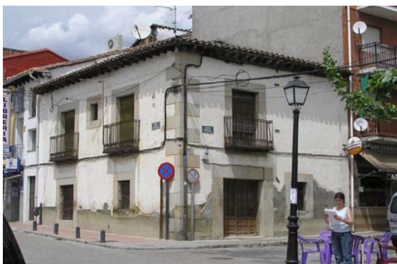
Esquina calle Nueva con calle Constitución
