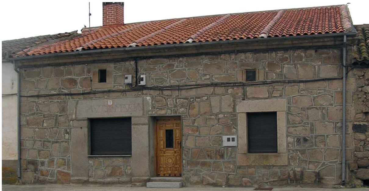
Vivienda de sillares de granito en la Calle Mayor numero 7 de Cardeñosa
