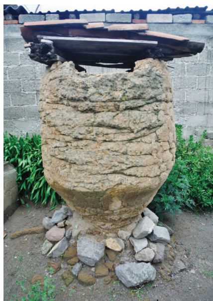
Figura 5. Cuexcomate de tamaño pequeño, que permite apreciar la base cilíndrica de piedra con diámetro de 63 cm y altura de 25 cm, el cuerpo u olla de tepetate y zacatillo con un diámetro de 1.15 m y altura de 1.4 m con cubierta de estructura de madera a un agua protegida por teja de barro. Además de visualizar las capas circundantes que conforman las paredes. Municipio de Contla de Juan Cuamatzi, Tlaxcala. 2017. Fuente: archivo personal.
