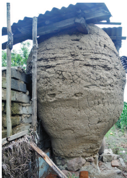
Figura 4. Cuexcomate que permite apreciar la estructura completa y la composición de cada una de sus partes: Base, Cuerpo y Cubierta. Municipio de Contla de Juan Cuamatzi, Tlaxcala, 2017. Fuente: archivo personal.
