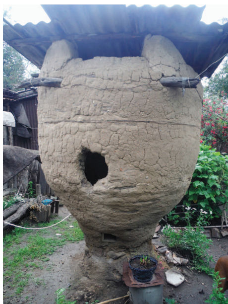
Figura 6. Izquierda. Cuexcomate con al menos 45 años de erigido, que permite la apreciación de los elementos que lo constituyen (base, cuerpo y techumbre) y la utilización de materiales de origen local, excluyendo la techumbre de asbesto símbolo de la sustitución a materiales de origen prefabricado. Predio de la Sra. Manuela Flores. Municipio de Contla de Juan Cuamatzi, Tlaxcala. 2017. Archivo personal. Derecha. Esquema que permite apreciar la estructura del Cuexcomate. Elaboración propia.
