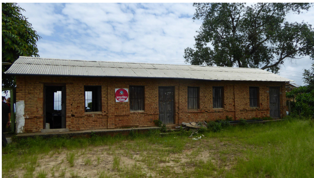
Figura 4. Edificio E1 antes de su demolición. Se puede observar la marca roja impuesta por los ingenieros nepalís. Fuente: Francesc Massó.
