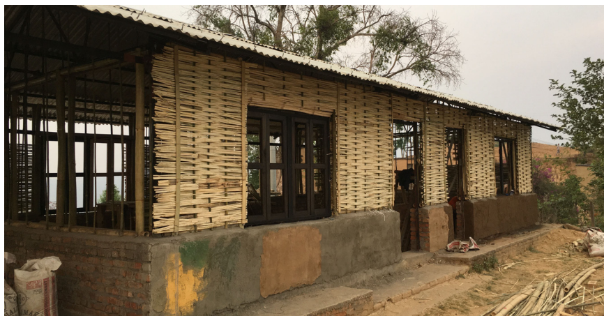
Figura 6. Muro de Bahareque del edificio E1 durante su ejecución. Fuente: Francesc Massó.
