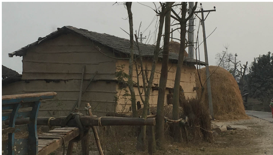
Figura 1. Ejemplo de vivienda tradicional con cerramientos elaborados con la técnica del Bahareque en la zona del Terai, Nepal. Fuente: Francesc Massó.
