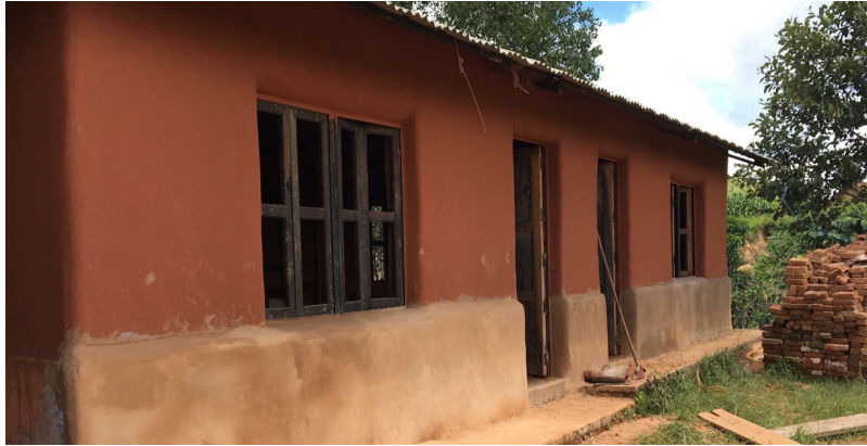
Figura 9. Muro de Bahareque acabado con todas las capas del revoco de barro finalizadas. Fuente: Recoop Nepal, Autor: Raúl Marroquín.
