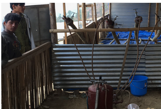
Figura 7. Tratamiento del bambú local con el sistema Modified Boucherie Technique o Sap Displacement Technique (Técnica del desplazamiento de la Savia). Fuente: Recoop Nepal. Autor: Arnau Mestre.
