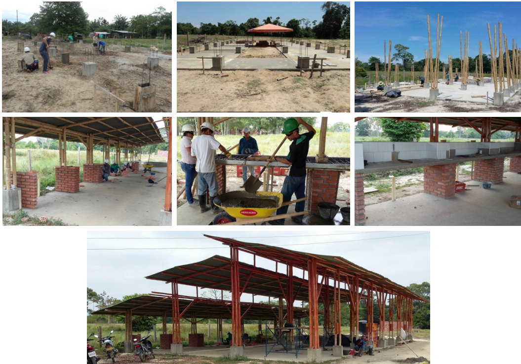
Figura 3. Construcción del taller de bio-construcción y acondicionamiento del laboratorio de investigación, vereda J10 del municipio de Tibu, región del Catatumbo, Norte de Santander, Colombia. Fuente: Oswaldo Hurtado Figueroa, Instructor SENA, Regional Norte de Santander, Centro C.I.E.S.
