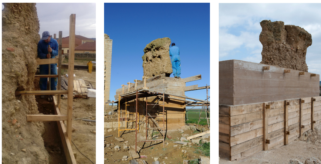
Figura 10. Fases en la reconstrucción del muro de tapia. Fuente: los autores.
