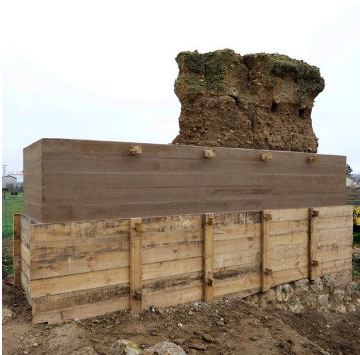
Figura 9. Aspecto final de la intervención realizada, donde se aprecia la disposición del encofrado sobre la base de mampuestos de piedra, el recrecio y el muro original. Fuente: los autores.
