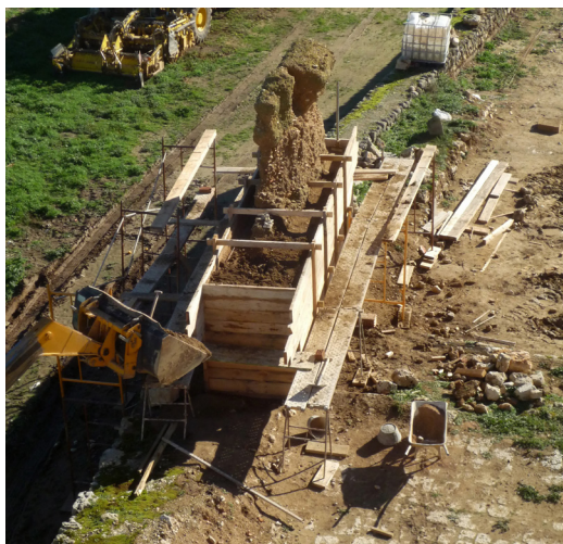
Figura 8. Vista, desde la torre del castillo, del cajón de madera durante las labores de reconstrucción del muro. Fuente: los autores.
