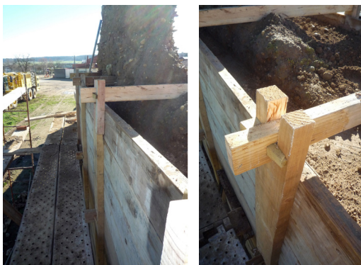
Figura 6. Soluciones de sujeción de los costeros y agujas al encofrado de tablonos mediante cuñas. Fuente: los autores.
