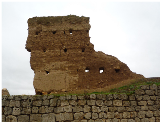
Figura 4. Caras Sur y Norte del muro de tapia, donde se aprecian los mechinales que permitieron la colocación de las agujas de sujeción de los cajones durante su construcción. Fuente: los autores.
