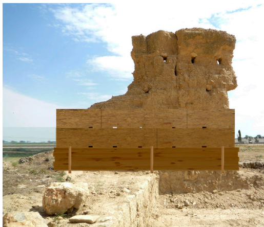
Figura 5. Estudio de disposición del encofrado de tablonés y simulación gráfica de la reconstrucción de la tapia. Fuente: los autores.
