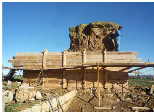
Figura 7. Proceso de reconstrucción, donde se aprecia la disposición del encofrado de tablonos apoyado sobre la cimentación de mampuestos. Fuente: los autores.
