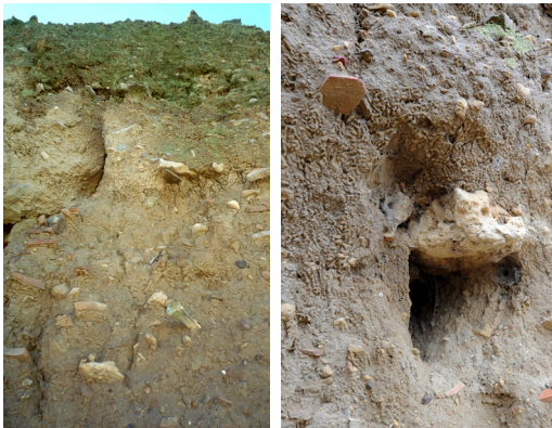
Figura 3. Detalle del muro, donde se aprecian huesos y trozos de cerámica en su composición. Fuente: los autores.
