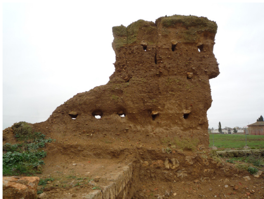
Figura 4. Caras Sur y Norte del muro de tapia, donde se aprecian los mechinales que permitieron la colocación de las agujas de sujeción de los cajones durante su construcción. Fuente: los autores.
