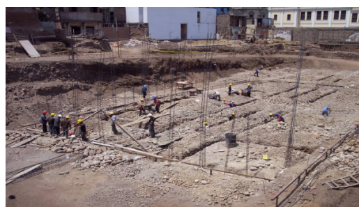
Figura 3. Excavación bajo el nivel de la calle. Fuente: Archivo EMILIMA.
