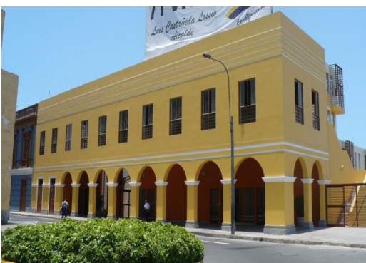
Figura 4. Reconstrucción de fachada en arcos. Fuente: Archivo EMILIMA.
