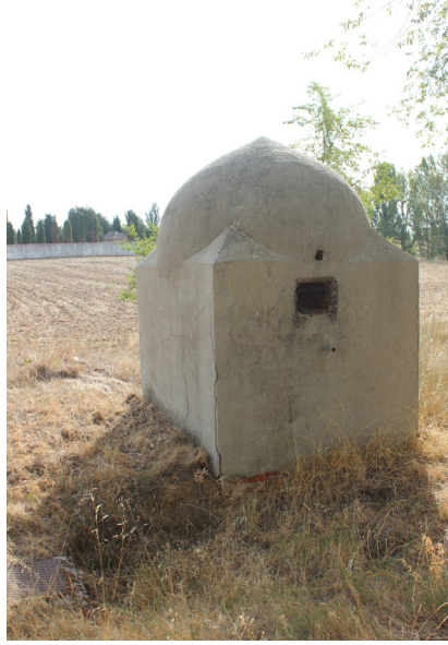
Figura 7. Caseta del pozo airón. Fuente: NOA 2 Arquitectura ambiental.
