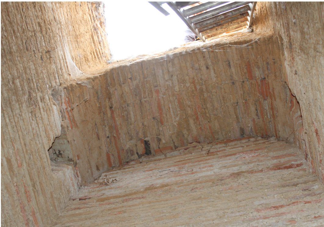
Figura 6. Arcos de medio punto, fábrica de ladrillo para sujección de accesos. Fuente: NOA 2 Arquitectura ambiental.
