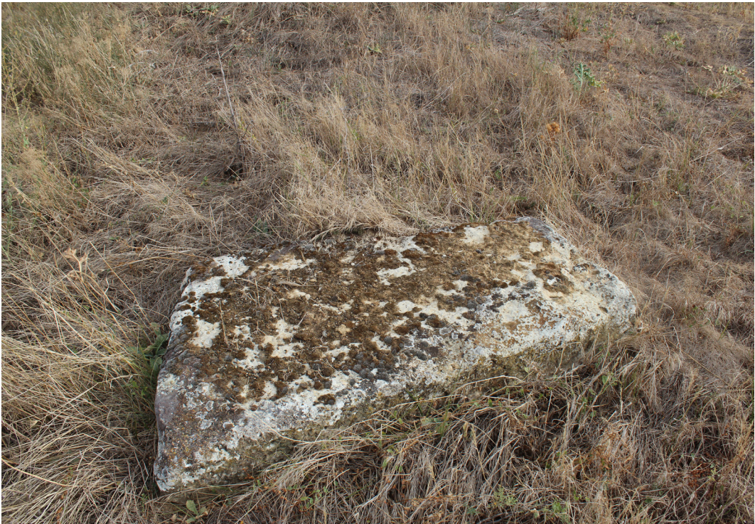
Figura 2. Tapas de los registros de piedra caliza. Fuente: NOA² Arquitectura ambiental.
