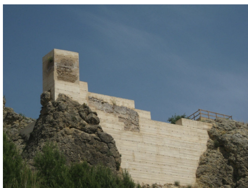
Figura 3. Restauración con recuperación de volúmenes perdidos, diferenciando zonas originales y dejando las agujas de madera vistas. Castillo de San Juan en Calasparra, Murcia. Fuente: Pedro Collado Espejo.
