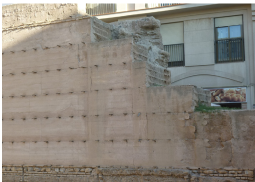
Figuras 1 y 2. Envejecimientos transcurridos unos años de la restauración, donde se pueden observar los efectos de las agujas de madera vistas, los desprendimientos debidos al agua de lluvia. Muralla de Verónicas, Murcia. Fuente: Pedro Collado Espejo.
