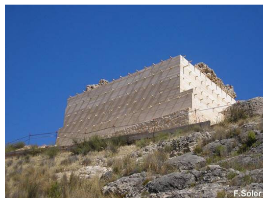
Figura 4. Restauración con recuperación de volúmenes perdidos, diferenciando zonas originales y dejando las agujas de madera vistas. Castillo de San Juan en Calasparra, Murcia. Fuente: F. Soler.
