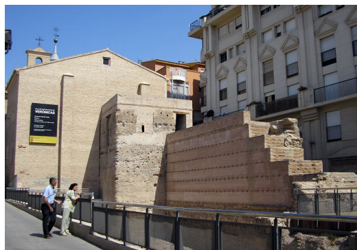
Figuras 1 y 2. Envejecimientos transcurridos unos años de la restauración, donde se pueden observar los efectos de las agujas de madera vistas, los desprendimientos debidos al agua de lluvia. Muralla de Verónicas, Murcia. Fuente: Pedro Collado Espejo.
