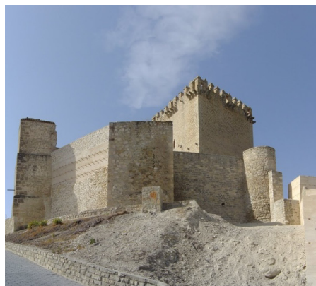
Figura 5. Estado primitivo y estado restaurado recuperando los volúmenes perdidos y dejando las agujas de madera vistas. Castillo de Moratalla, Murcia Fuente: F. R. García M.
