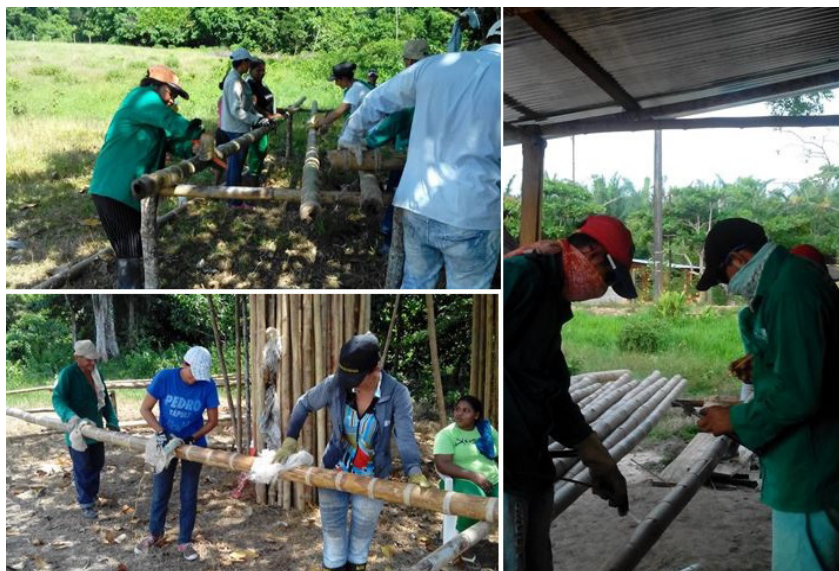
Figura 4. Vista limpieza e inmunización de la Guadua taller de Bio-construcción en la vereda J10 del municipio de Tibu, región del Catatumbo, Norte de Santander, Colombia. Fuente: Oswaldo Hurtado Figueroa, Instructor SENA, Centro CIES.
