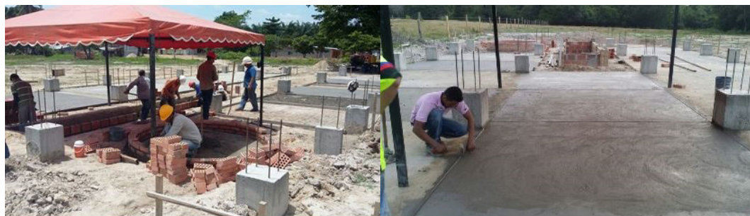
Figura 2. Vista construcción de cimentación y mampostería taller de Bio-construcción en la vereda J10 del municipio de Tibu, Catatumbo, Norte de Santander, Colombia. Link video 2 https://www.youtube.com/watch?v=DO3f7dwlmU0 . Fuente: Oswaldo Hurtado Figueroa, Instructor SENA, Centro CIES.
