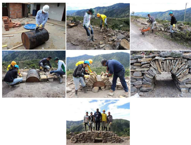
Figura 7. Vista construcción de puente en piedra seca en el municipio de San Calixto, región del Catatumbo, Norte de Santander, Colombia. Fuente: Oswaldo Hurtado Figueroa, Instructor SENA, Centro CIES.
