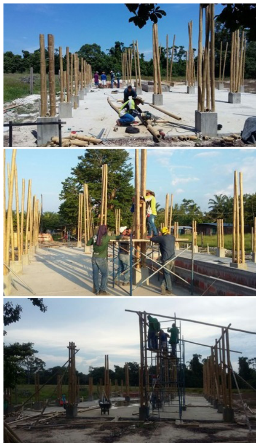
Figura 5. Vista armado de estructura en Guadua taller de Bio-construcción en la vereda J10 del municipio de Tibu, región del Catatumbo, Norte de Santander, Colombia. Link video 4 https://youtu.be/nlv1Y5w-PLE
