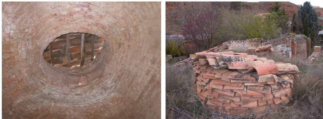
Figura 5. Cúpula de ladrillo del Horno 1 y remate superior del óculo.
