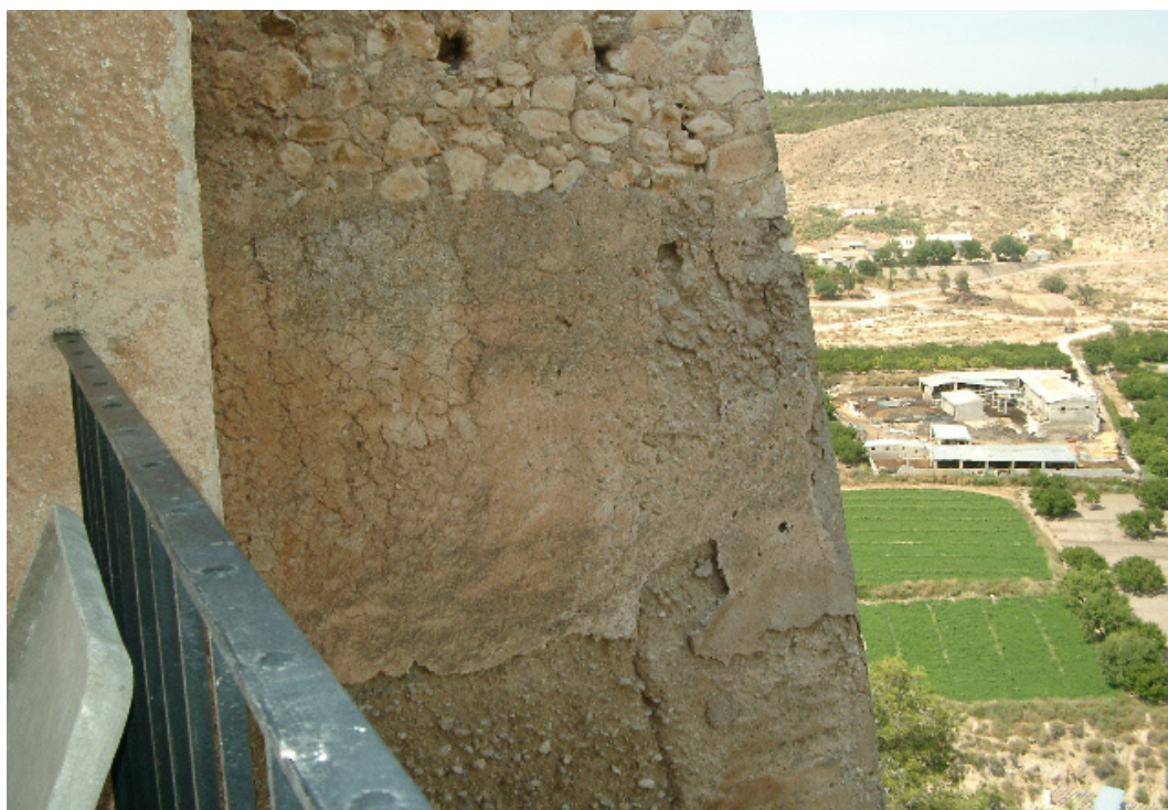
Figura 1. Vista exterior de una de las caras de la Torre antes de la intervención. Fuente: Antonio González Quirós.
