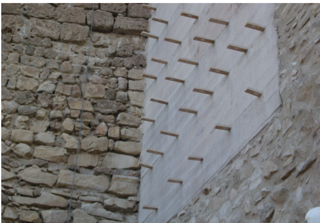
Figura 6. Lateral de la Torre terminado con las agujas de madera vistas. Fuente: Antonio González Quirós.
