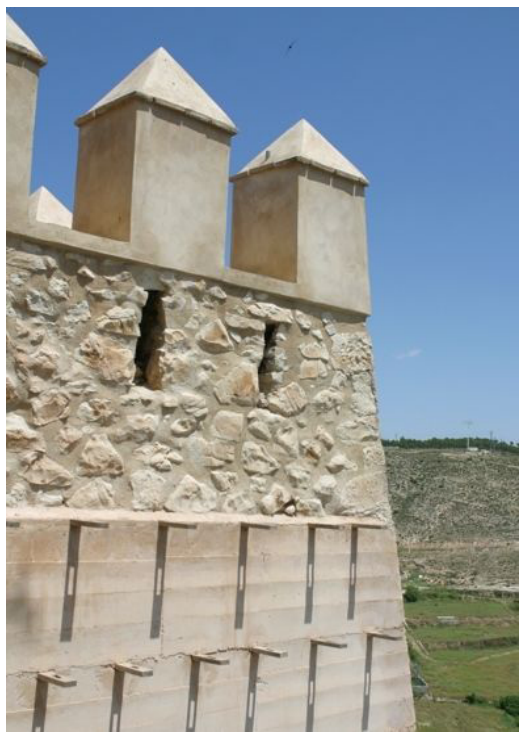
Figura 7. Detalle de zona alta de la Torre después de la intervención. Fuente: Antonio González Quirós.
