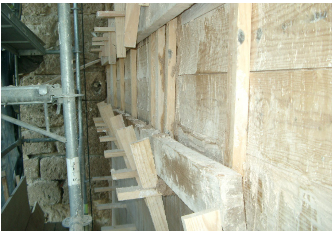
Figura 5. Detalle del tablero del tapial colocado a una cara. Fuente: Antonio González Quirós.
