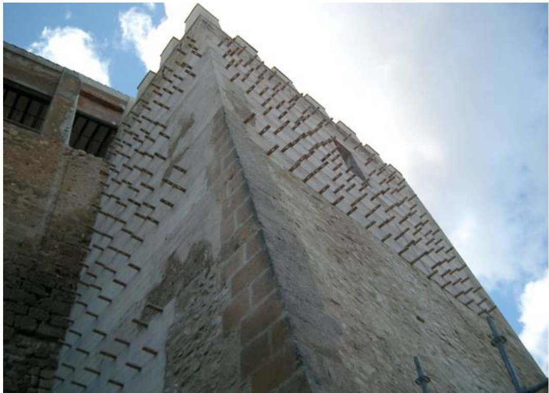
Figura 8. Vista completa de una de las caras de la Torre después de la intervención. Fuente: Antonio González Quirós.
