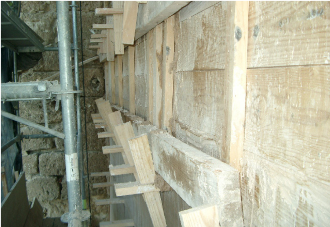
Figura 4. Tablero del tapial colocado a una cara para recuperación volumétrica de una de los lados de la Torre. Fuente: Antonio González Quirós.
