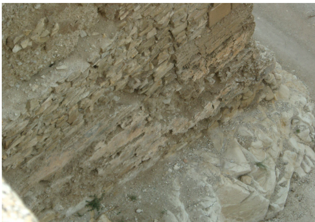
Figura 2. Base rocosa de asiento de la Torre antes de la intervención. Fuente: Antonio González Quirós.
