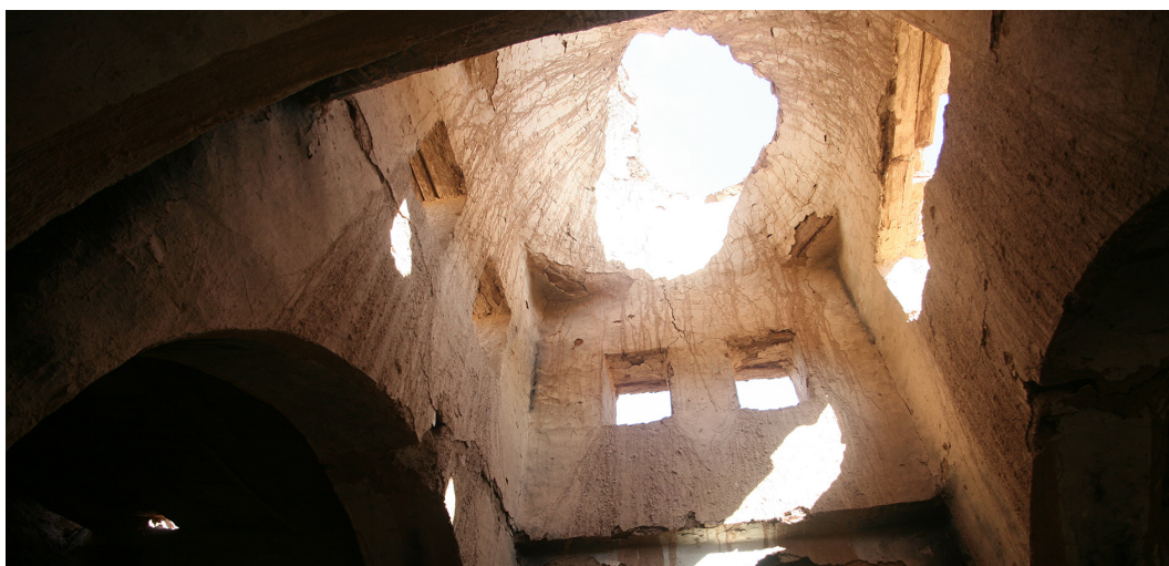
Figura 4. Vista interior del remate de la cúpula del morabito. Vista interior. Abril 2014. Fuente: Rodríguez&Gil.
