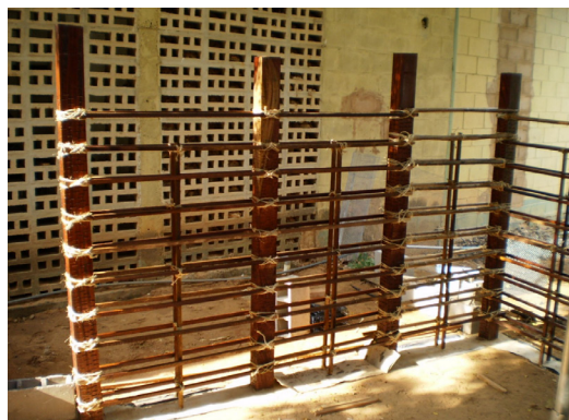
Figura 1. Armazón del bahareque Fuente: Henneberg de León (2009)
