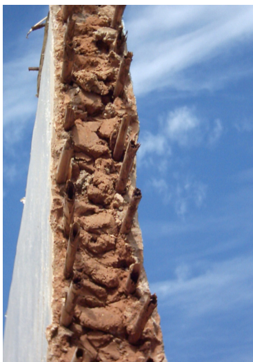
Figura 5. Grosor de una pared de bahareque de 15 cms
