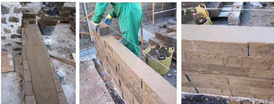
Figura 5: Junta con lechada fluida.
