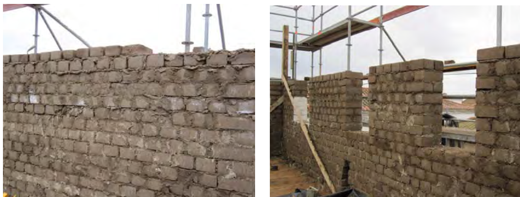
Figura 6: Junta con mortero.
