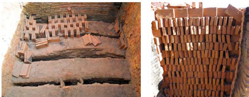
Figura 5. A la izquierda el horno cuando se empiezan a colocar los ladrillos sobre los arcos ejecutados sobre el fuego. A la derecha los ladrillos colocados “encastillados” para permitir el paso del calor del fuego. Fotografías de los autores.
