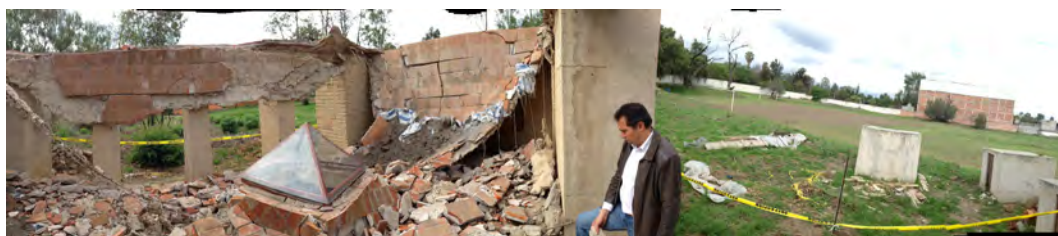
Figura 8. Colapso del prototipo © LITEC
