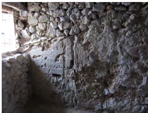
Fig. 6.-Detalle de los tapiales en las obras en curso en el edificio de la Antigua Cárcel y Biblioteca municipal.
