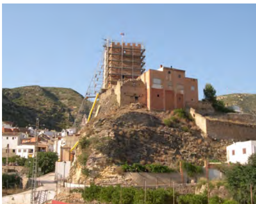
Fig. 4.- Vista general de la torre del castillo durante la primera fase de su restauración, 2005.
