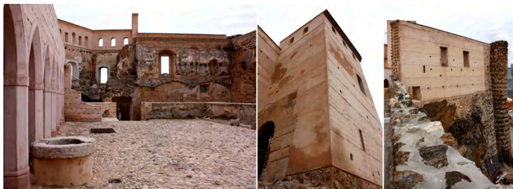
Figura 7. Imágenes del estado actual del Castillo de Cofrentes. Fotos de autor.
