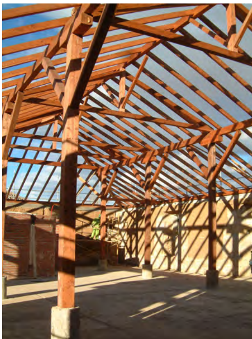
Figura 5. Montaje de estructura de madera. Fuente: J.R. Sola
