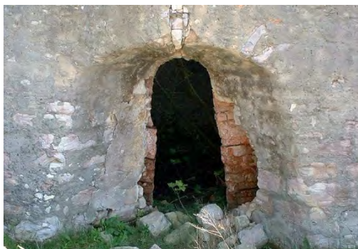
Figura 7. a) e b) Forno de cal em adobe, Cantanhede, boca do forno e entrada. Fonte: Luís Santiago
