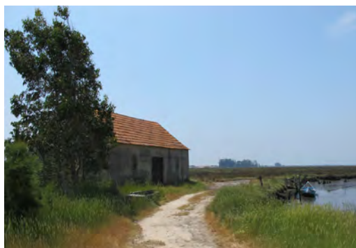
Figura 2. Edifício em adobe, concelho da Murtosa, Ribeira do Martinho. Fonte: Autores
