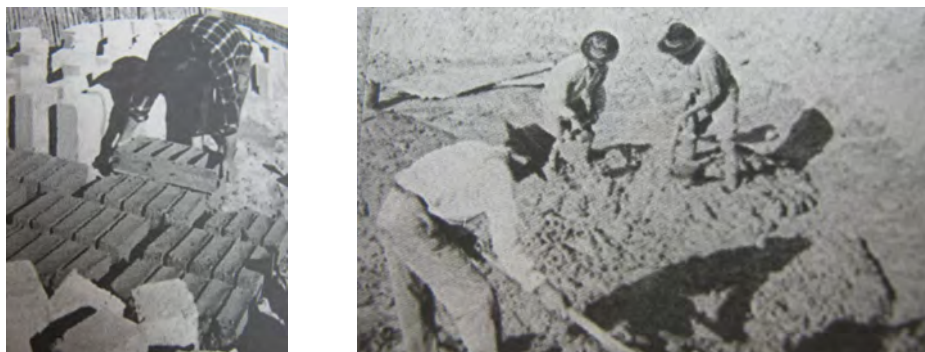
Figura 6. a) Extração das areias (areiros) b) desmoldagem do adobe de diferentes tamanhos, meados do século XIX. Fonte: “Arquitectura Popular em Portugal”, João Afonso et al
