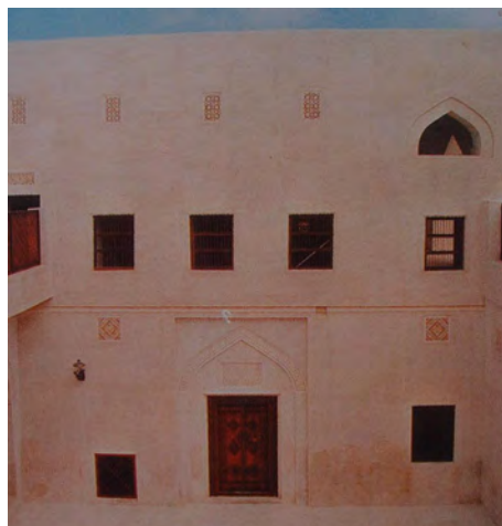
Figura 7. Fachada del dormitorio en el patio privado. Fuente: Casa-museo.
