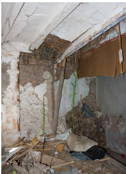
Figura 7. Interior barraca. Detalle refuerzo de muro con troncos de árbol y forjado de cañizo (Pastor 2011)
