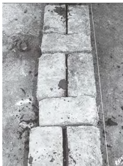
Figura 6. Detalle de traba de gassons (Rubio 1999, 35)
