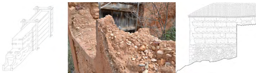
Figura 4. Detalle de la ejecución de tapia con brenca de yeso y mampuestos de refuerzo / Detalle de una brenca de yeso y su ubicación en las caras exteriores y no en todo el espesor del muro. Despiece de la fachada noreste de la Casa Abadía de Castielfabib (Vázquez-Esparza, Álvaro)
