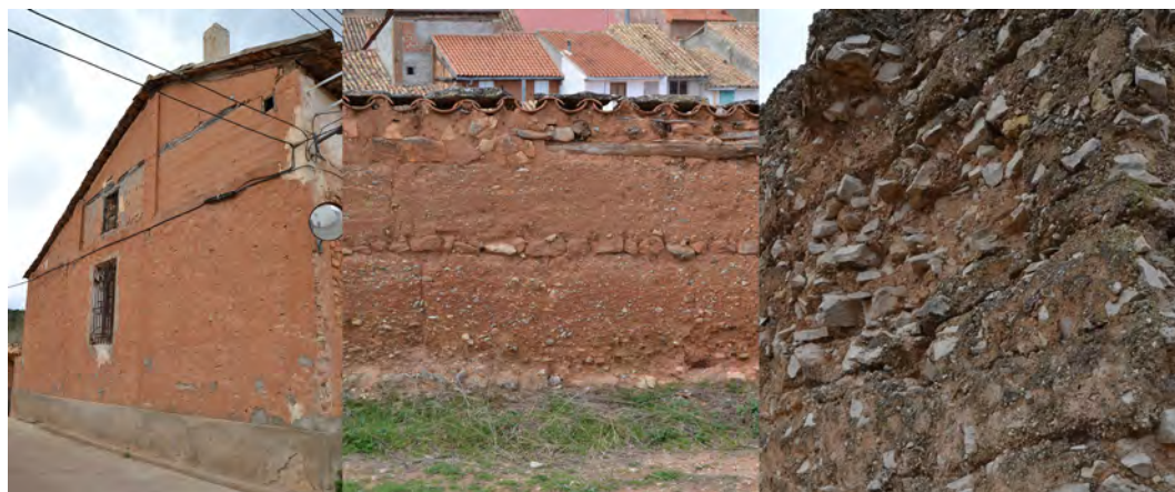
Figura 1. Tapia de yeso en una vivienda de Torrealta / Tapia de tierra con pequeños mampuestos en un pajar de Torrealta / Tapia de hormigón de cal con mampuestos en masa en la Torreta de Castielfabib (Vázquez-Esparza, Á)
