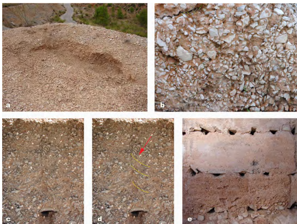
Figura 3. a- Graveras próximas a Almudaina. b- Roca conglomerada situada a los pies de la torre. c- Tapia y mechina por la cara exterior. d- Idem con indicación de la dirección del pisado. e- Tapia interior con apoyo en basamento. Fuente: F.Vilàplana.
