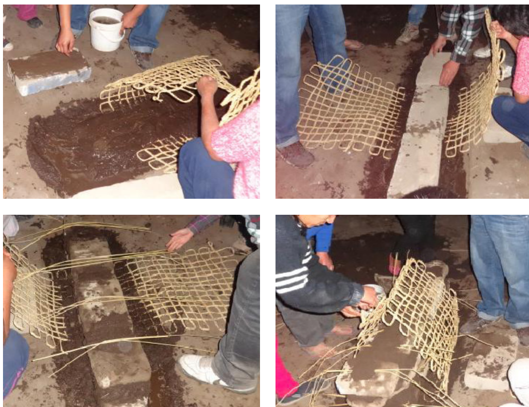
Figura 6 Colocación de la malla en muro. Fuente: CECOS-BRIGURP 2013.
