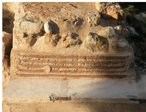
Figura 5. Frente del paso de ronda una vez terminados los trabajos. Sobre los dos muros, ocultos por el muro de la torre construido, se levanta la capa de tierra apisonada de tonalidad rojiza, otra capa de mampuestos y hormigón de cal, y, en el borde, el arranque del antepecho. El rollizo que se observa correspondía, muy probablemente, a un refuerzo de la estructura. Fuente: F. Font.
