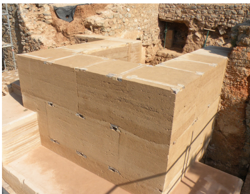
Figura 3. Vista general de la torre norte con las soluciones adoptadas indicadas. A la derecha de la torre el paramento del muro de tapia de tierra de tonalidad rojiza sobre el que se intervendrá, y sobre este el único vestigio del paso de ronda de lo que fue el castillo musulmán. También a la derecha de la torre se observa el espacio dejado sin muro para que se puedan visualizar los motivos decorativos del paramento de la torre primera. Fuente: F. Font.
