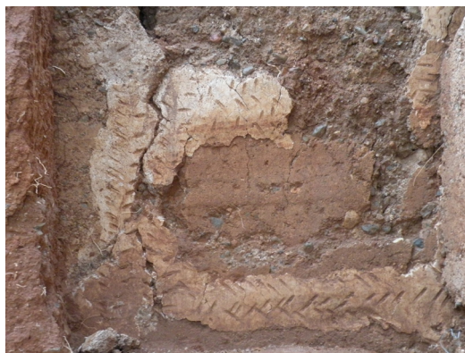
Figura 2. Motivos decorativos en el paramento exterior del muro de la torre norte. Fuente: F. Font.
