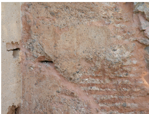
Figura 4. Vista parcial del paramento después de la intervención. Puede observarse el afloramiento de la tierra y el mechinaal dejado por la media aguja empleada en la ejecución del muro. Fuente: F. Font.
