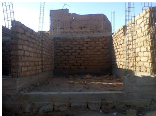
Figura 5. Construcción de una vivienda en M'Hamid en la cual se combinan materiales tradicionales como adobe de tierra y estructura en hormigón armado. Fuente: Anna Rico.
