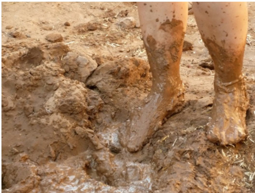
Figura 2. Ejecución del amasado del mortero de adobe. Fuente: Anna Rico.
