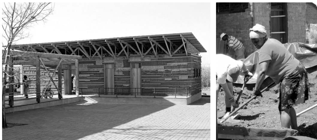
Figura 8. LivingTebogo – casas para crianças com deficiência em Joanesburgo, África do Sul. O projecto foi desenvolvido por estudantes da Universidade de Linz (BASEhabitat) e pelo arquitecto Martin Rauch, em 2005. Este edifício proporciona um excelente conforto interior durante todo o ano, sem recurso à energia eléctrica, numa região onde a temperatura se pode tornar insuportável durante o Verão. Foram utilizados materiais económicos, ecológicos e disponíveis no local: terra, adobe, palha e madeira (fonte: archdaily.net).
