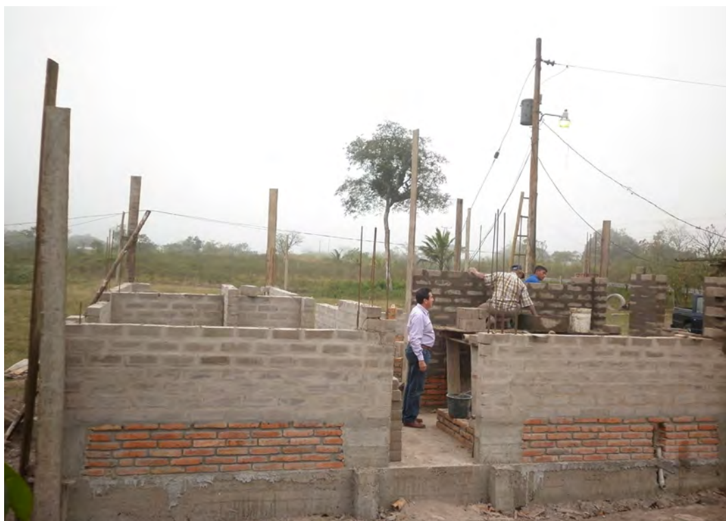
Figura 6. Construcción de la vivienda experimental en El Aromo.
