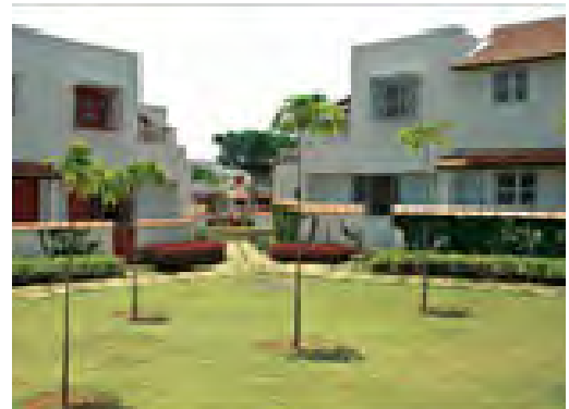
Imagen No. 20: VISTA DESDE EL PATIO COMUNAL
