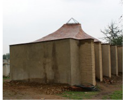
Fig. 8.- El módulo experimental con la cubierta ya concluida, revestida con ladrillo de barro cocido. Fuente: Mario Larrondo.
