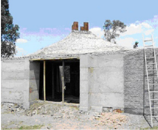
Fig. 7.- Cubierta con cuatro superficies alabeadas soportadas por sendas nervaduras. Fuente: Luis Guerrero
