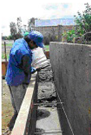
Fig. 5.- Vertido del barro estabilizado con cal y cemento en el encofrado, para la conformación de los muros del ala oriente del Módulo. Fuente: Luis Guerrero
