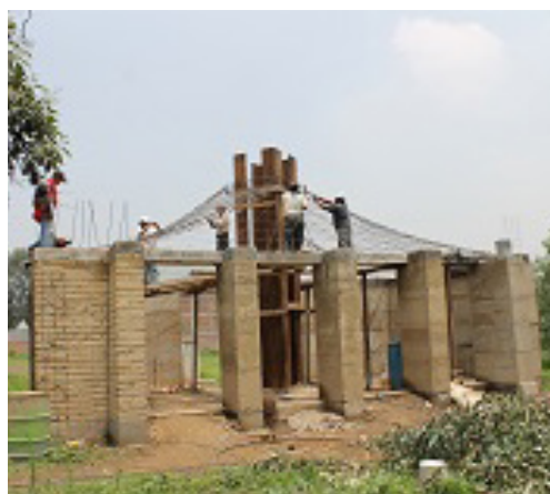
Fig. 6.- Estructura portante de malla metálica para el techo. Fuente: Francisco Javier Soria
