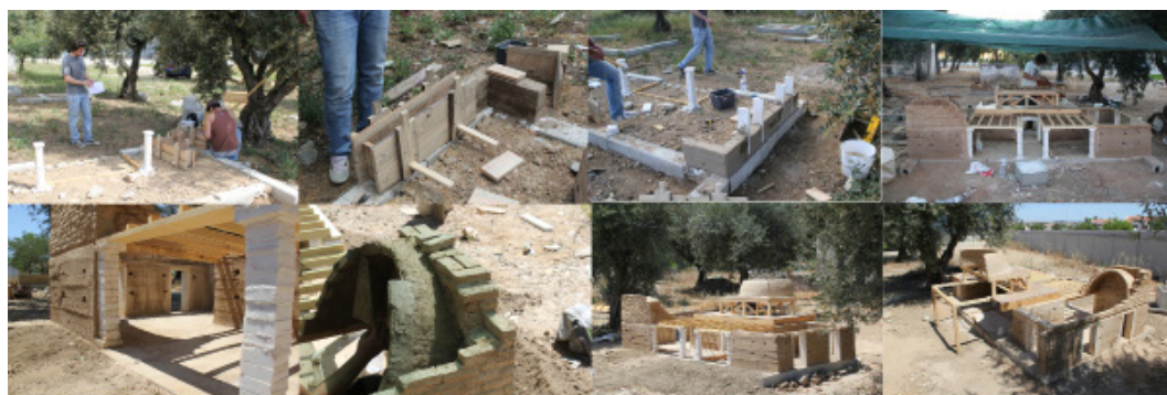
Figura 6. “Maquette”: Paredes em taipa e adobe, pilastras em mármore. Cobertura em abóbada núbia e cúpula esférica em adobes, estrutura de madeira.
