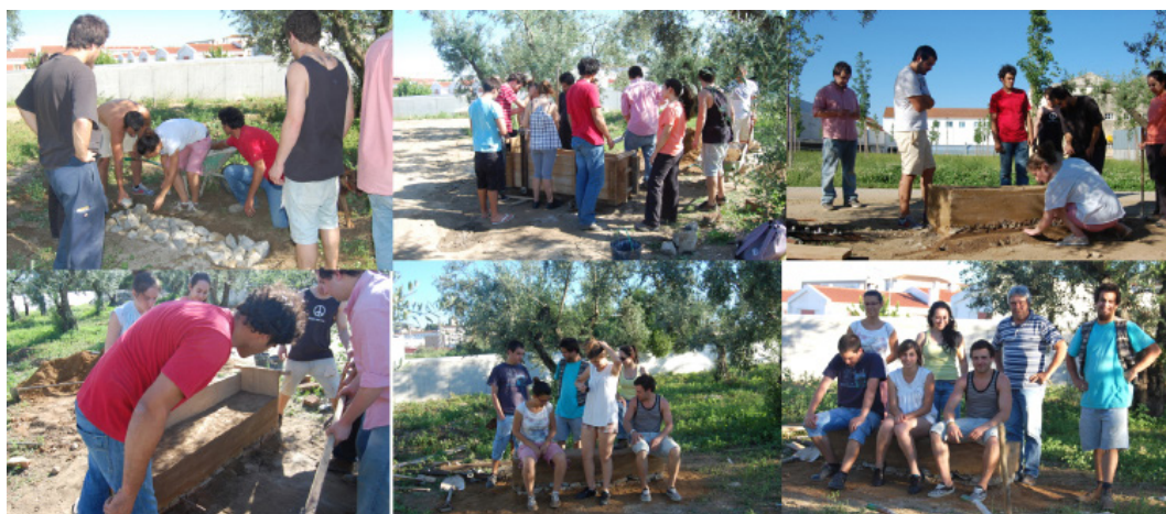
Figura 3. “Workshop” de execução de dois bancos em taipa no Pólo dos Leões, da Univ. de Évora. Créditos: António Borges Abel
