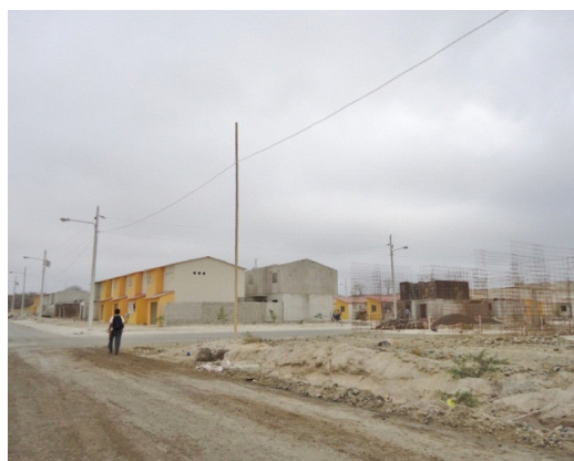
Fig. 5.- Programa de Vivienda Municipal “Si Vivienda”, se empezó a construir en el 2011 la primera etapa de 800 viviendas. Al fondo modelos de viviendas en dos plantas, prefabricadas con paredes de hormigón, a la derecha se aprecia la estructura de la vivienda previa a la fundición.
