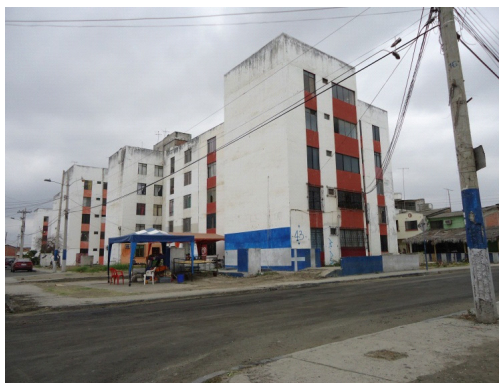
Fig. 3.- Plan Habitacional "El Palmar", construido en 1984 por la Junta Nacional de Vivienda del BEV, ubicado al noreste de la ciudad, se establecen 835 soluciones habitacionales entre viviendas de una planta y bloques de departamentos.
