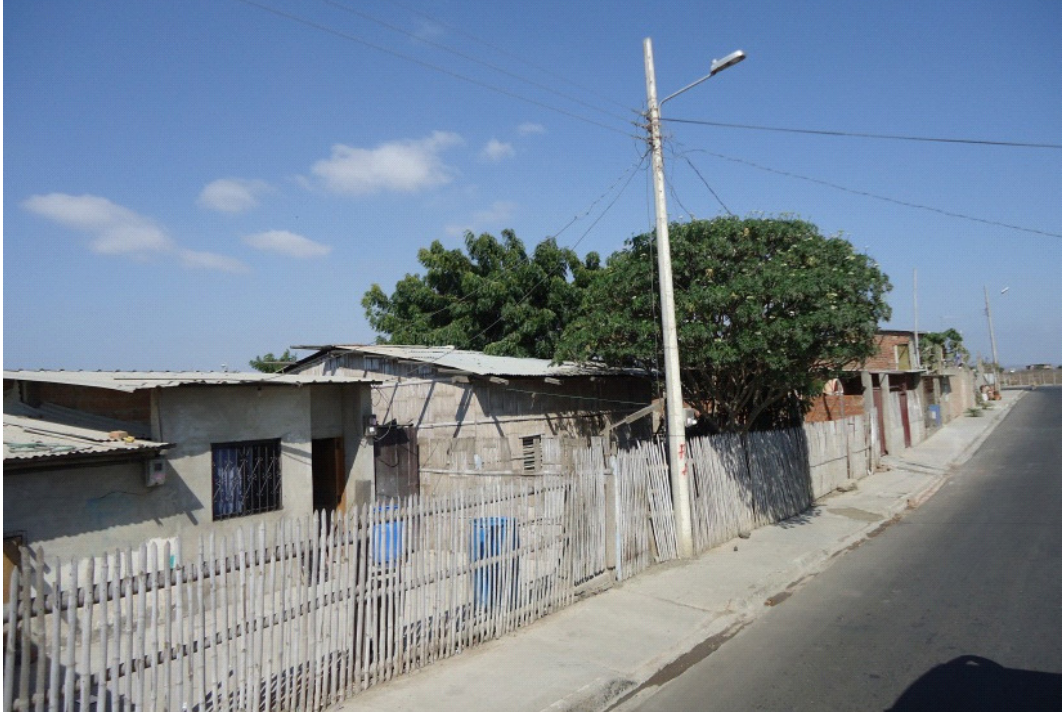
Fig. 4.- Plan de Mejoramiento Integral del Barrio Urbirrios, inicia en 1998 con la planificación de lotes, el municipio financia infraestructura en conjunto con el MIDUVI, la comunidad en ciertas áreas ayuda con mano de obra.
