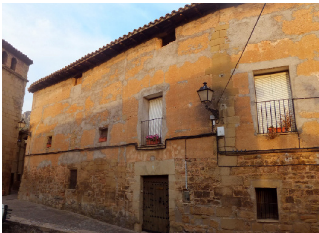
Figura 1. Construcciones de tapia en en Agüero (a 10 km. de Ayerbe) y su suelo (Àngels Castellarnau).
