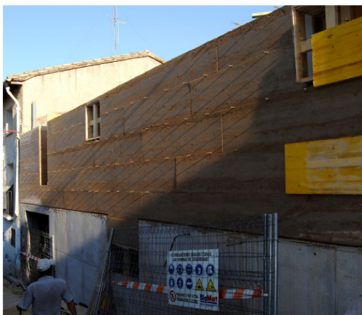
Figura 6. Desencofrado de la tapia (Àngels Castellarnau)
