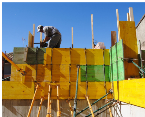
Figura 4. Encofrados de madera (Àngels Castellarnau)
