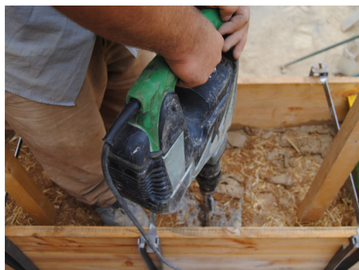
Figura 3. Ejecución de la tapia apisonado mecánico (Àngels Castellarnau)
