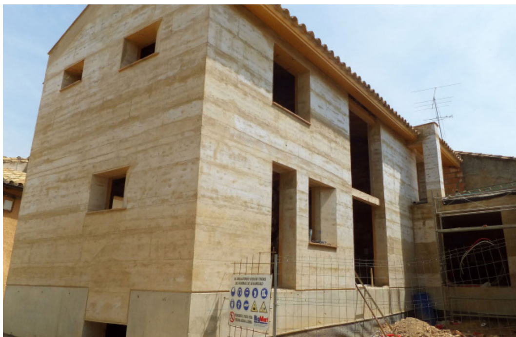
Figura 8. Fachadas sur y oeste acabadas (Àngels Castellarnau).
