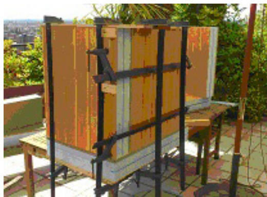
Figura 3. Encolado y ensamblaje de los paneles.
