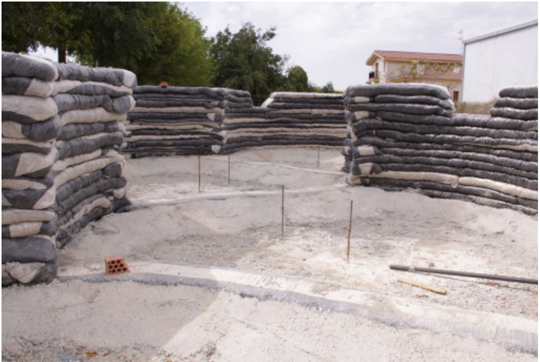
Figura 4. Vista del proceso constructivo desde el interior. Fuente: Pilar Díez.
