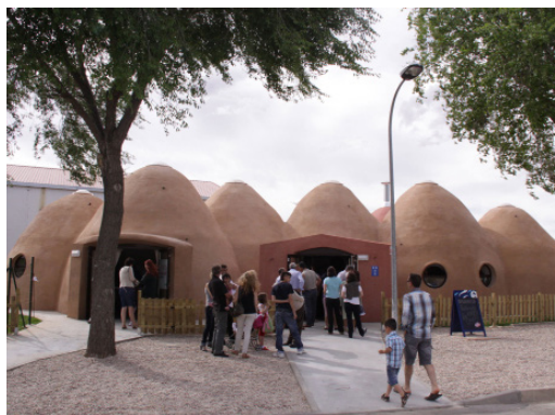
Figura 3. Vista de la fachada principal. Fuente: Pilar Díez
