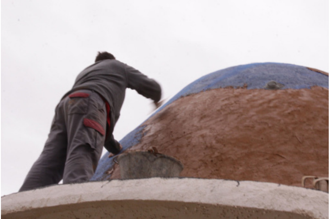
Figura 7. Proceso de revoco exterior. Fuente: Pilar Diez.
