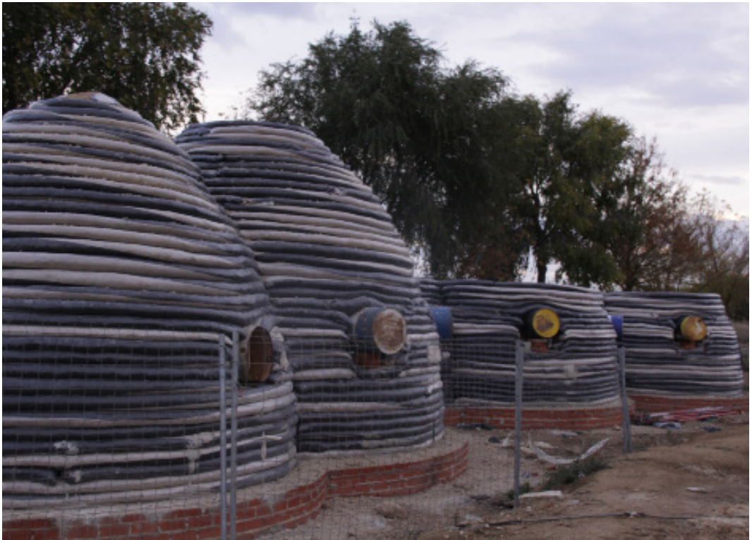
Figura 5. Vista del proceso constructivo desde el exterior. Fuente: Pilar Díez.
