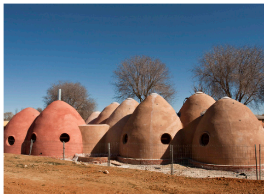
Figura 2. Vista posterior del edificio en la fase de acabados de la obra. Fuente: Pilar Díez.
