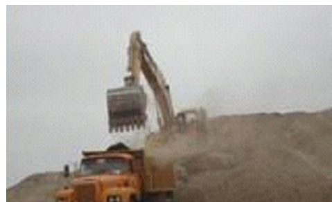
Fig. 4.- "El Aromo", Ingreso de la cantera Vipa y cargada del material seleccionado (Fuente Francisco Vera)
