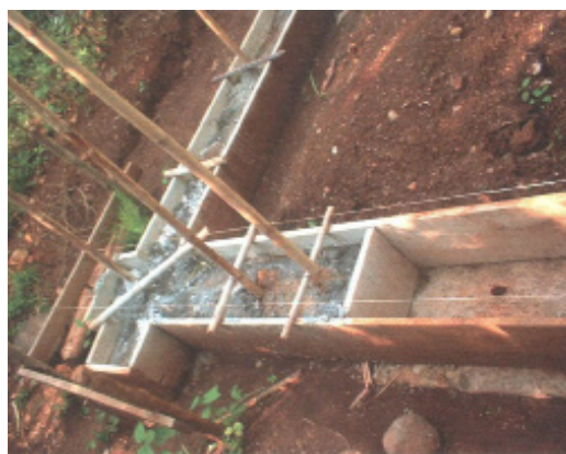
Fig.4.- Construcción del murete de fundación encima de la cimentación.
