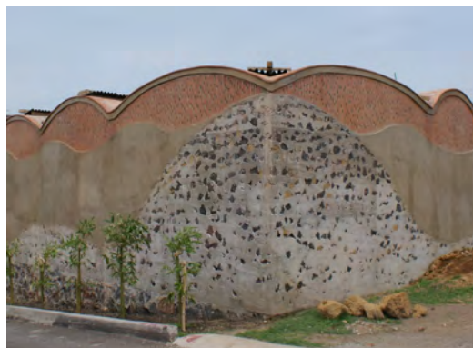
Viviendas en Tlayacapan, México.
