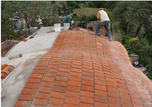
Bóvedas gaússas o de doble curvatura en Ludoteca en Petlascalco, México. Capa impermeabilizante de ladrillo. Fuente: Jaell durán Herrera.
