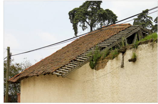
Fig. 5. Imagen donde se muestran los materiales constructivos empleados para la techumbre. Foto: Omar Peña.
