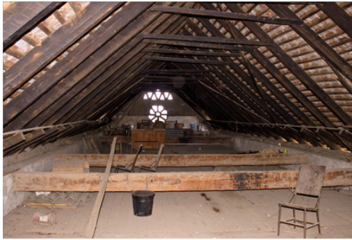
Fig. 4. Imagen del interior de la troje donde se muestra el sistema constructivo de la arquitectura típica de Ayapango. Foto: Oscar Reyes.
