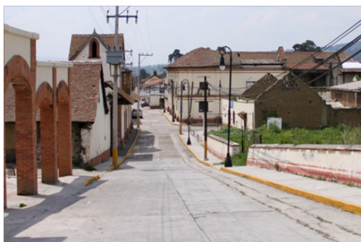
Fig. 2. Imagen de la calle Hidalgo en su estado actual. Foto: Oscar Reyes.
