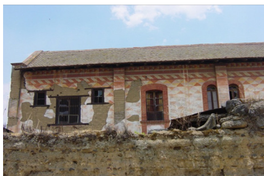
Fig. 10. Imagen del deterioro en exteriores que presenta una de las casas que conserva el patrón de pintura geométrico a base de pigmentos. Foto: Leonardo Meraz.
