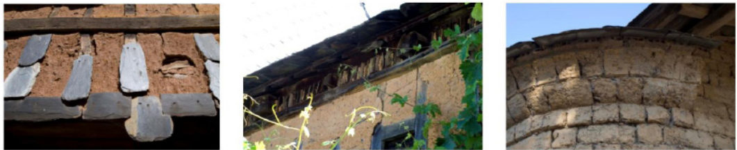
Figura 6. Detalles constructivos. (Fotos: M.R.Velasco).
