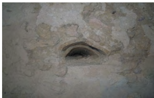
Imagen 7. Muro interior de la torre de la iglesia de San Esteban, Cuéllar. Hueco para pasar las agujas realizado con teja.
