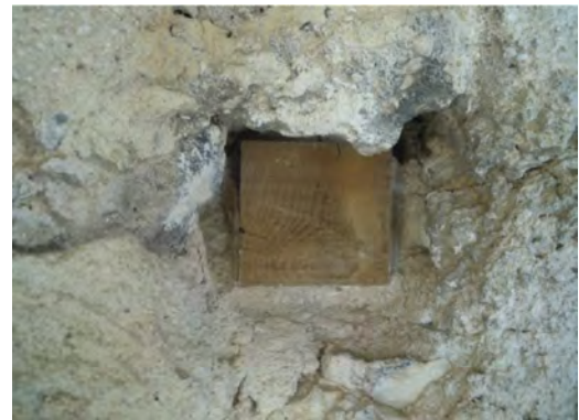
Imágenes 11 y 12. Muro interior de Nuestra Señora de la Cuesta. Agujas cortadas en el interior del muro.
