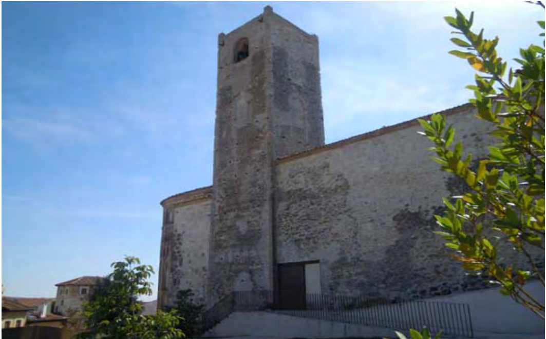
Imagen 15. Torre-campanario de la iglesia de San Esteban de Cuéllar. Construida en tapia de calicanto.
