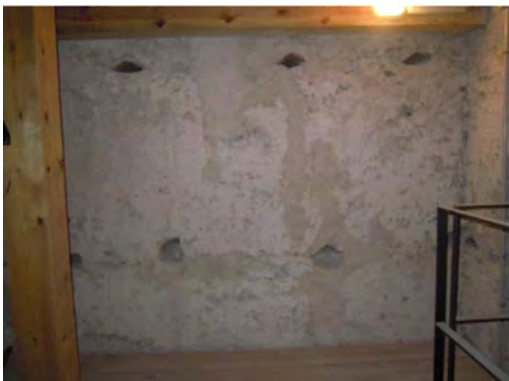
Imagen 16. Interior de la torre de la iglesia de San Esteban. Se aprecian los mechinales de las agujas del tapial.
