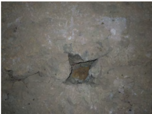
Imágenes 11 y 12. Muro interior de Nuestra Señora de la Cuesta. Agujas cortadas en el interior del muro.
