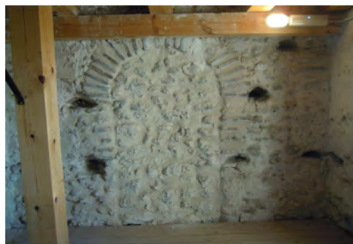
Imagen 5. Muro interior de la torre de San Esteban, Cuéllar. Se aprecia la fábrica de ladrillo conformando las jambas de la ventana que ha sido tapada.
