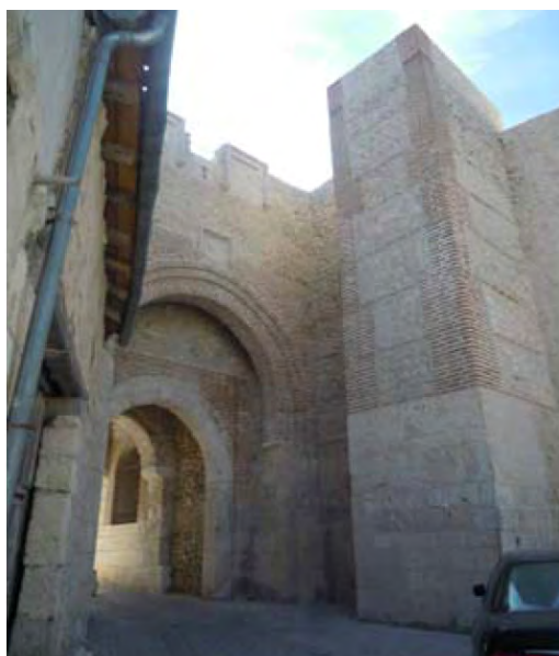
Imagen 1. Arco de San Basilio. Cuéllar. Pequeña fortaleza con torreón de planta rectangular, arco de triple anillo. Combinación de machones y verdugadas de ladrillo con cajones de mampostería.
