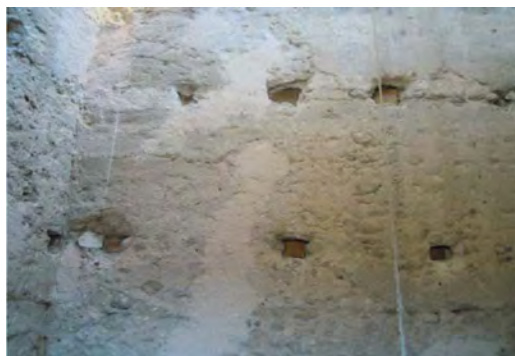
Imagen 4. Muro interior de la torre de la iglesia de Santa María de la Cuesta, Cuéllar. Se aprecian las agujas cortadas en el interior del muro.
