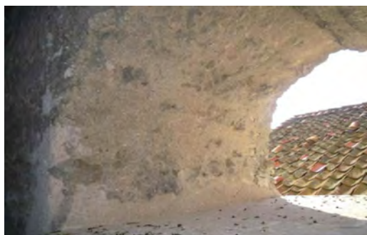
Imagen 6. Muro interior de la torre de la iglesia de Santa María de la Cuesta, Cuéllar. Hueco realizado con encofrado en la tapia.
