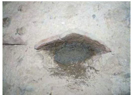
Imagen 17. Interior de la torre de la iglesia de San Esteban. Detalle del hueco del muro para pasar la aguja realizado con teja.
