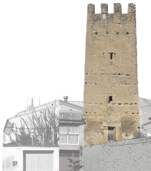
Fig. 2.- Alzado este. En esta fachada se encuentran la puerta de acceso original en primera planta, las aspilleras en segunda y tercera altura y las almenas rematando la torre. Fuente: Realización propia.
